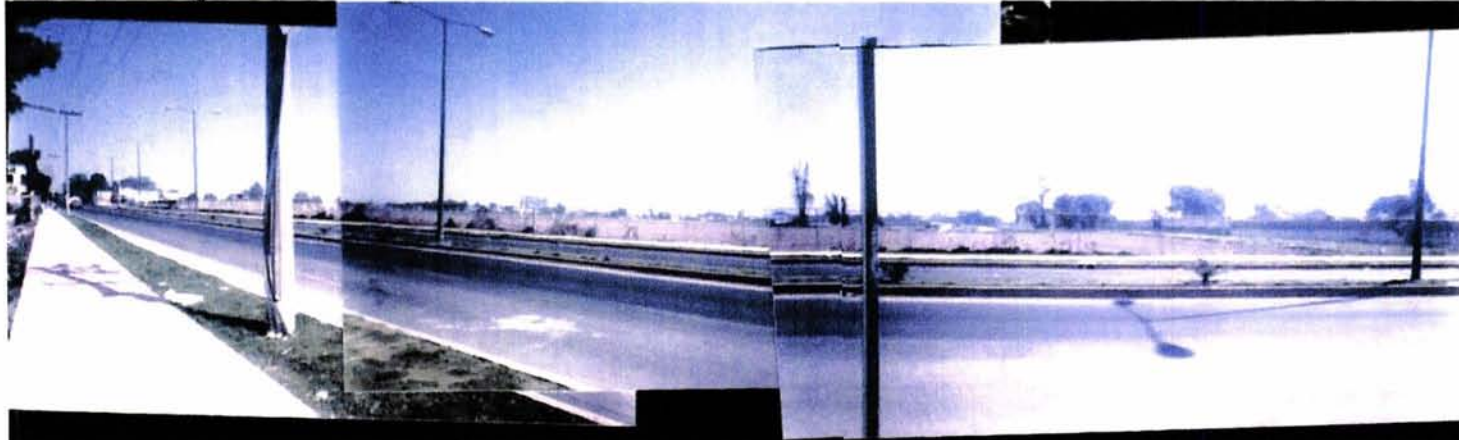
9. Terrenos frente a la fachada principal (Av.. Netzahualcoyotl), actualmente terrenos de cultivo, junto a estos en contra esquina de la Av.. Francisco I. Madero existe un rancho, al fondo una escuela.
