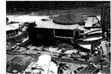
Vista Aérea del Conjunto Fotografía: Luis Gordo
