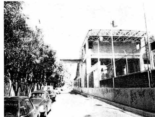
Instalaciones de la Estación Xochimilco del Tren Ligero. Ubicada sobre la Av. 20 de Noviembre.
