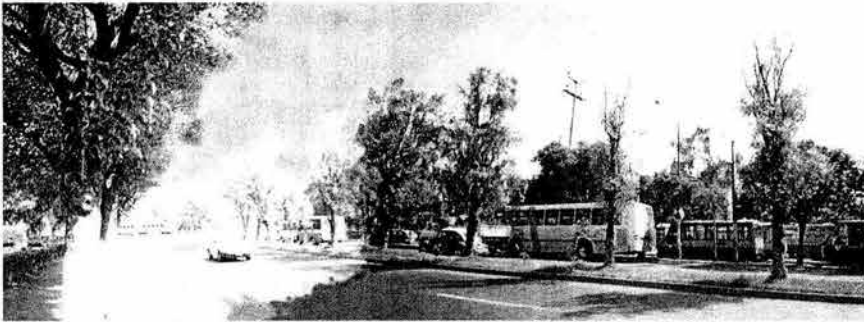
FOTO 1. Vista de la Av. Prolongación División Del Norte, con dirección al cruce del Tren Ligero. la cual cuenta con 3 carriles en cada sentido
