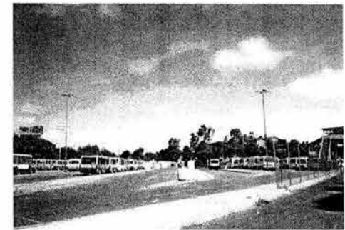
FOTO 5. Vista de Predio desde la calle Arroyo San Marcos.
