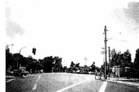
FOTO 11. Cruceo de la Av. Prolg. División y la Av. 20 de Noviembre.
