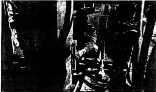
Figura 12. Colocación de tubería ranurada tipo canastilla.
