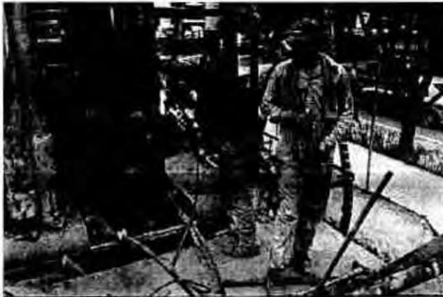
Figura 20. Detalle de soldadura de tubería con doble cordón.
