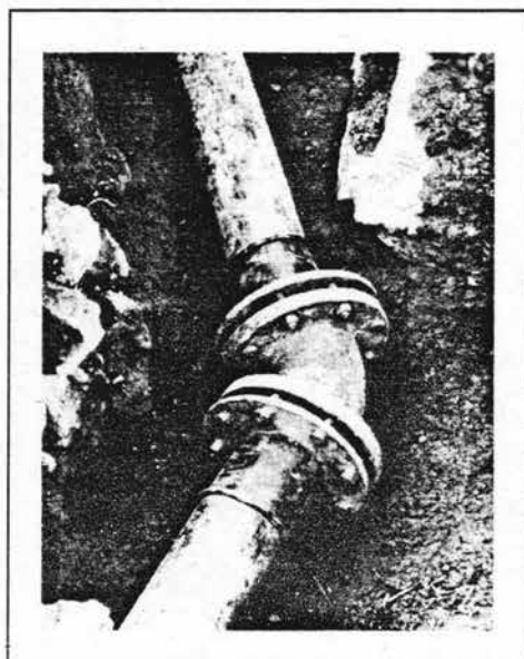
FIGURA V.19 TUBERÍA REPARADA
