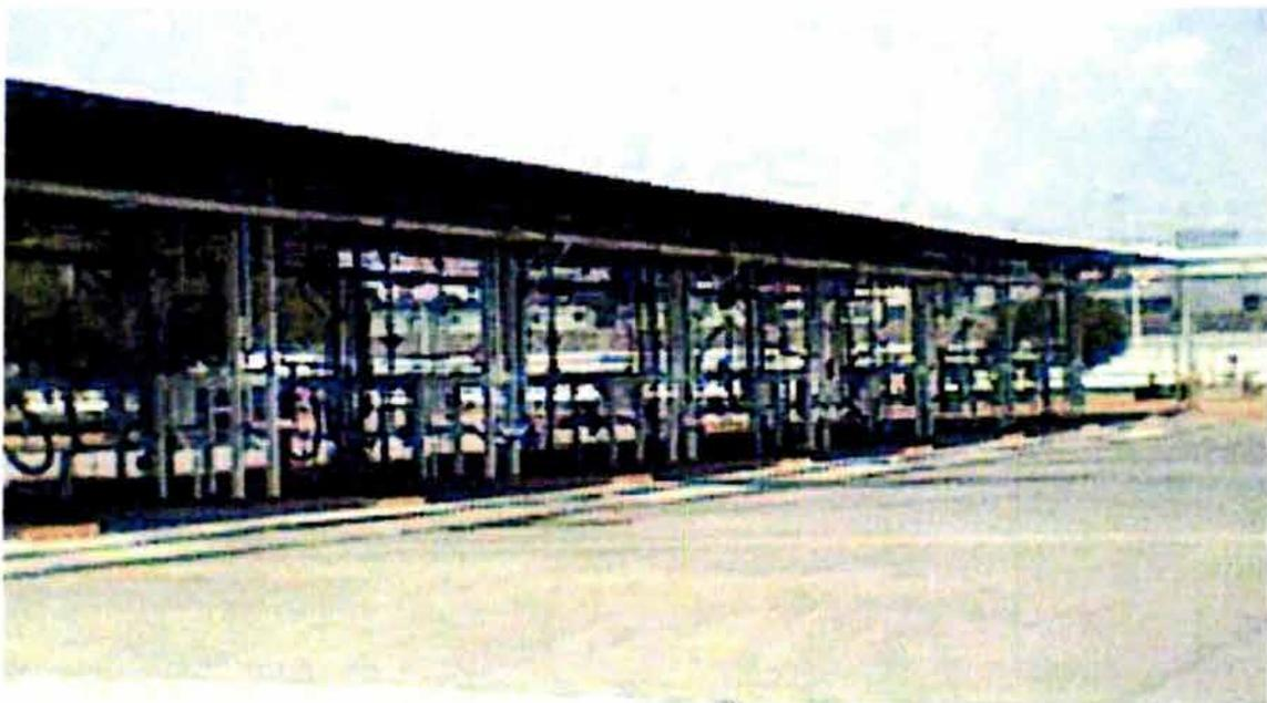
**Imagen de una nave de llenado, que a su vez se compone de 9 llenaderas, a donde los autotanques arriban a las diferentes islas para cargar producto**
