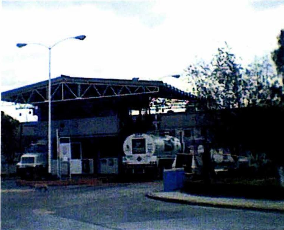
**Vista de la torre de control (pasarela) en donde se aprecia a dos autotanques, uno entrando para que el operador reciba un nuevo número de carga y el otro estando en posición para que se le coloquen los sellos en la caja de válvulas y en el domo por el portero checador**
