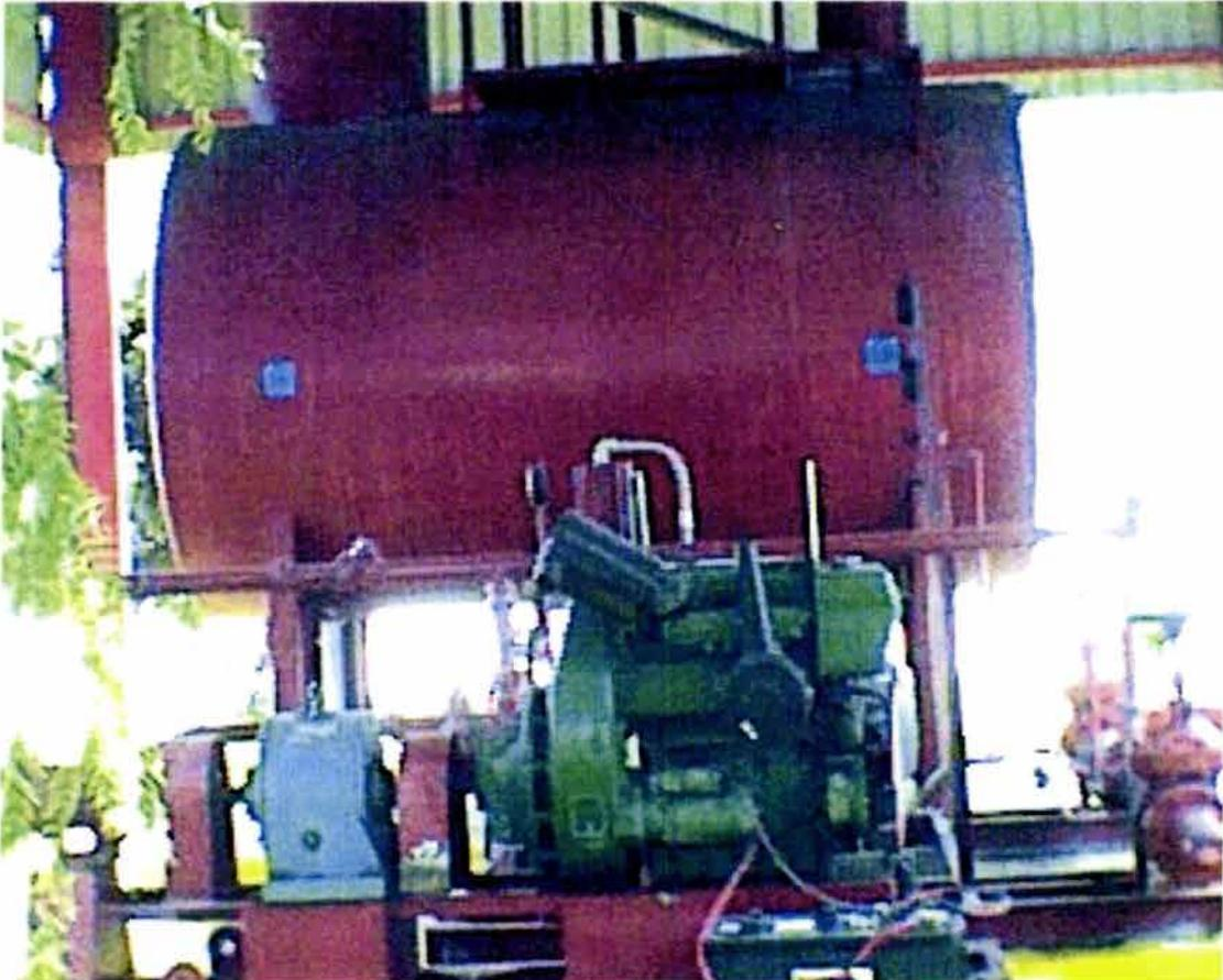
**Sistema de presión balanceada compuesto por un tanque de almacenamiento de agente espumante por una bomba eléctrica de agente espumante y una de combustión interna**
