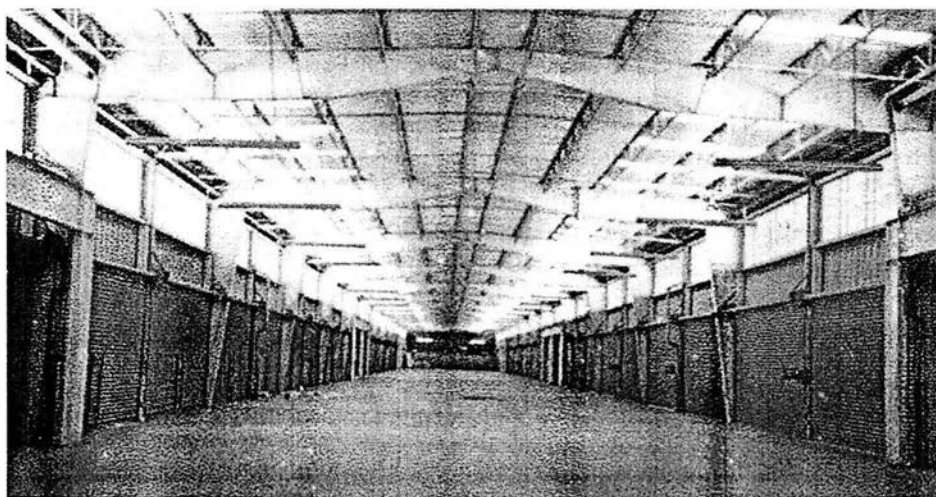
Figura 13. Vista interior de una Nave
