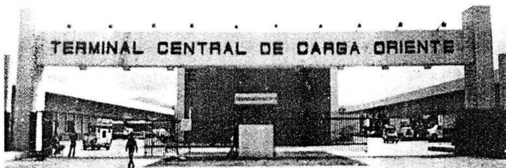
Figura 12. Vista de la Entrada y la Salida de la Terminal
