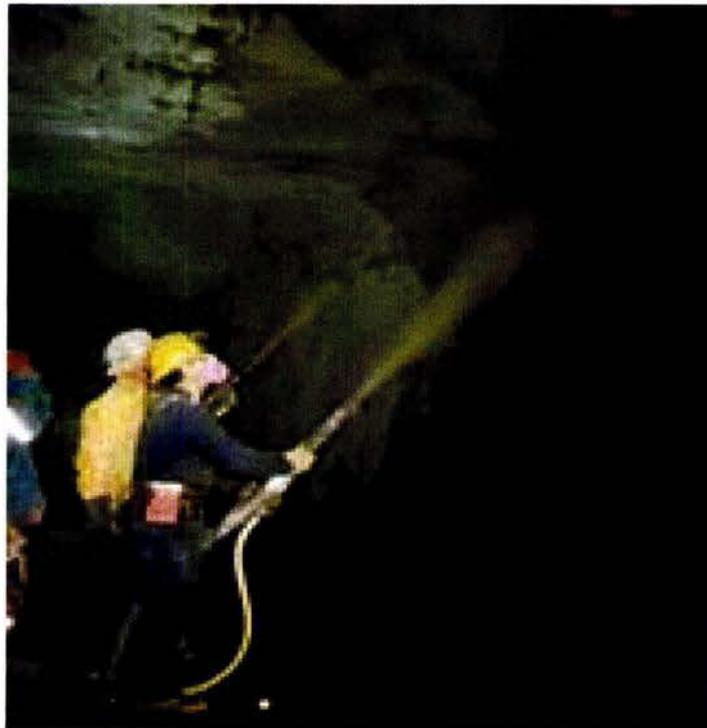
Figura IV.9 Revestimiento del túnel
