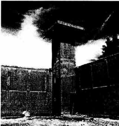
FOTO 58- Se observa la torre de vigilancia sobre el muro perimetral para la vigilancia del interior como del exterior.
