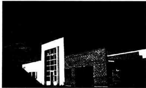
FOTO 53.- VENTANAS.- Se observa el uso de materiales como muros de concreto armado con aplanado de mezcla fino y pintura vinilica en tonos claros, se utiliza una modulación que se repite en la planta alta, en lo que se refiere a la cancelaría en las ventana es a base de perfil estructural logrando que se cree una volumetría en la fachada que rompe con la austendad del edificio con elementos tan simples que le dan mucha presencia a esta fachada en la parte exterior y en los interiores se hace uso de soleras que obstaculizan el paso en caso de fugas que siguen la modulación.
