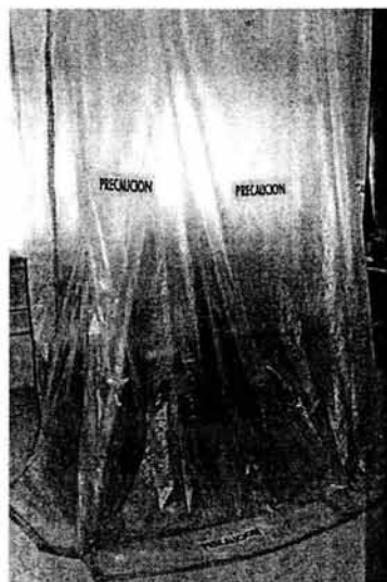
Figura 30. Área de trabajo. Está cubierta por plástico de piso a techo, a modo de evitar la intromisión de polvo al interior del detector.
