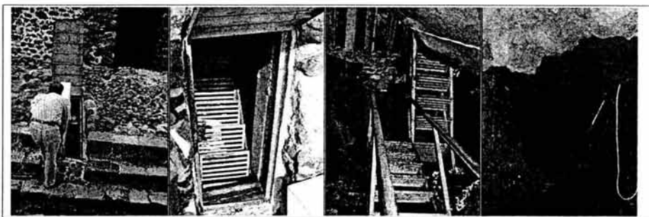
Figura 15. En las imágenes observamos la forma en que entrará el detector, así como parte del interior del túnel.
