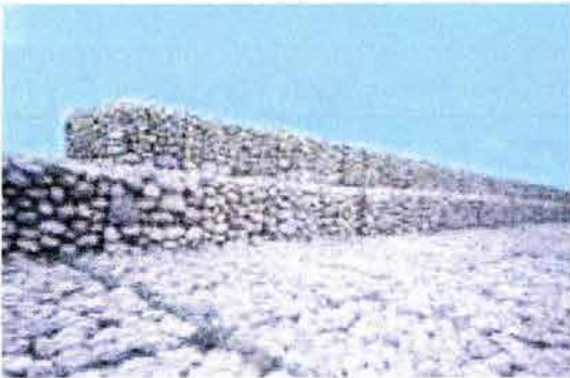
Imagen 69 vista de gaviones armados
