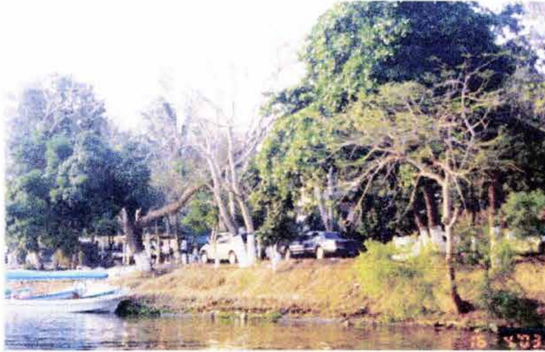
Imagen – 8 vista del borde del río erosionado
