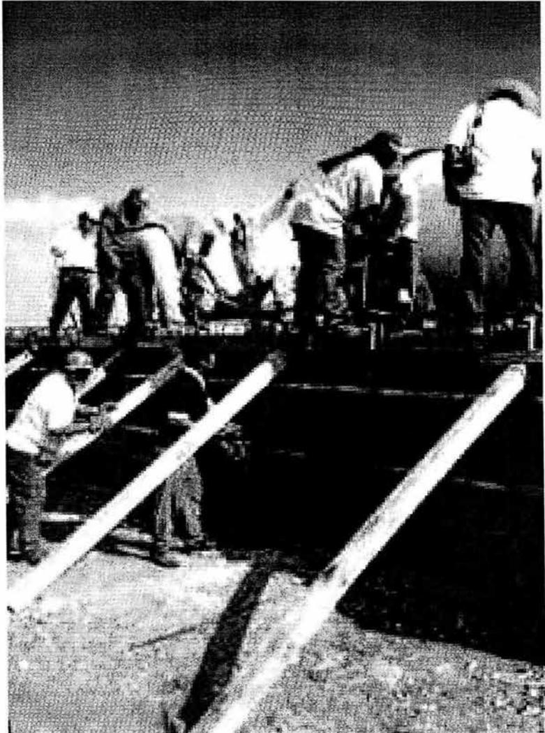
En la presente vista se aprecia el vibrado del concreto con vibradores de inmersión y de contacto.
