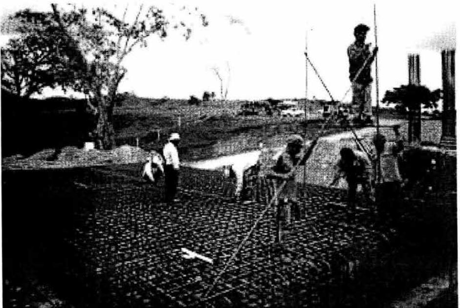
Armado de la zapata.
