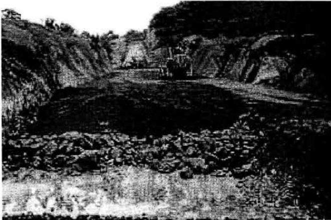
km. 215+000 atrás construcción de capa estabilizadora con material de tipo basáltico lado derecho
