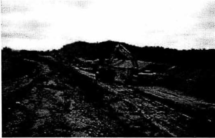
Km. 215+200 atrás excavación en caja con profundidades de 0.60 a 1metro y retiro de material saturado con camiones fleteros.
