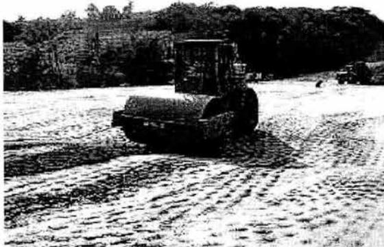
Formación y compactación de terraplén al 90%, realizado por un vibro compactador (rodillo vibratorio)
