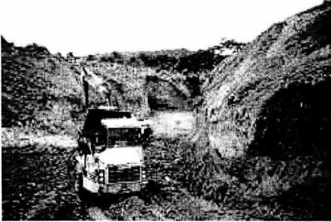
Excavación con una retroexcavadora 330 BL CAT y retiro del material con un camión articulado.
