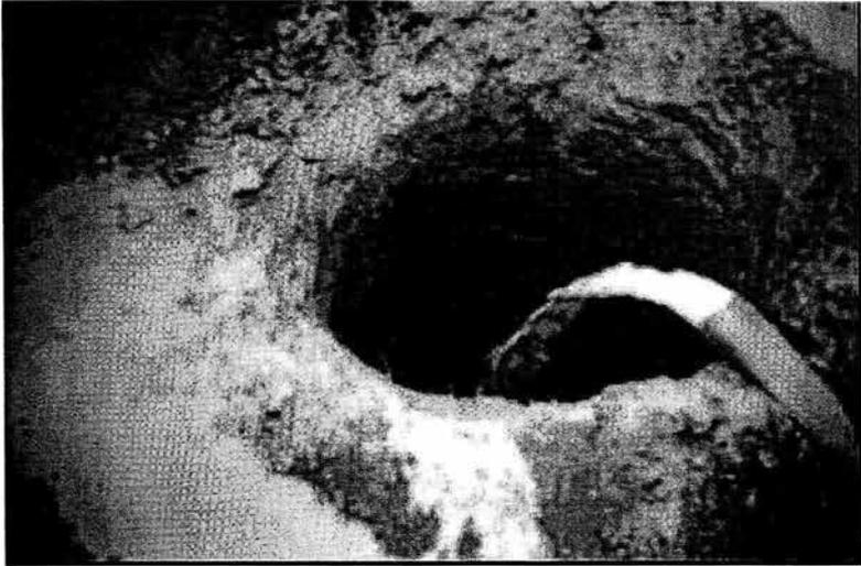
Bombeo de lodo bentonítico a la perforación que se encuentra en proceso para estabilizar las paredes, evitando deformaciones por caídos y por las cavernas que se forman en los suelos arcillosos blandos.
