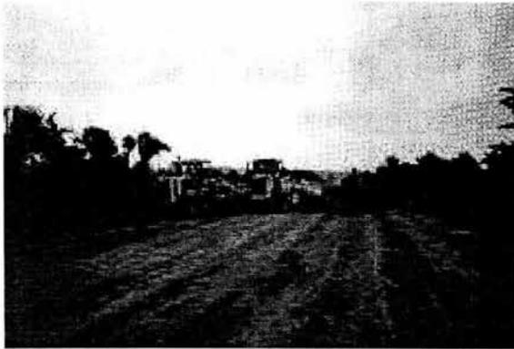
Riego de agua con pipa de 18,000 lts. para obtener la humedad óptima. Se aprecia la espera de motoconformadora CAT 14G para iniciar la homogenización.
