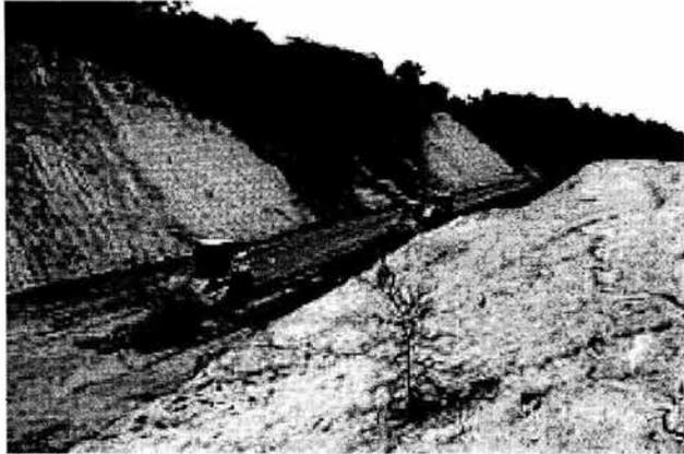
Km. 211+240 capa subrasante en proceso de construcción, vibrocompactadores CS563C dándole la compactación hasta alcanzar el 100 % de su PVSM.
