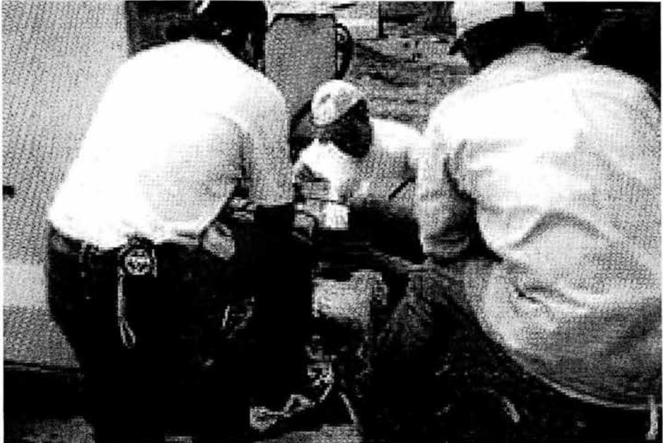
Se parecía el tensado y medición de los alargamientos del acero de preesfuerzo en la trabe.
