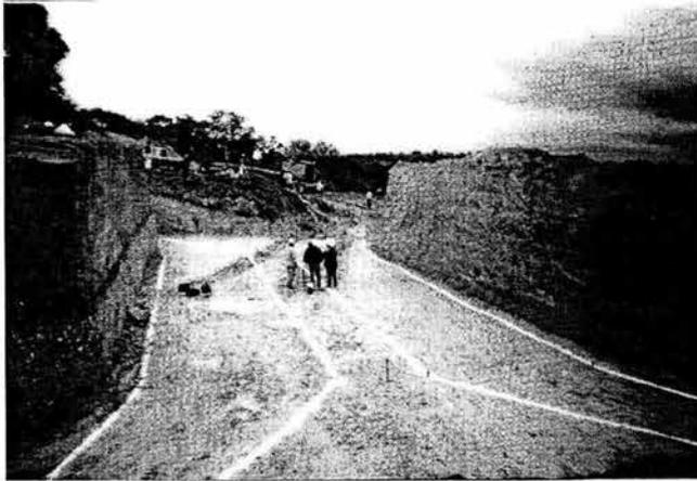
Excavación a nivel desplante con la capa estabilizadora ya construida y el trazo para construir la plantilla de concreto simple.
