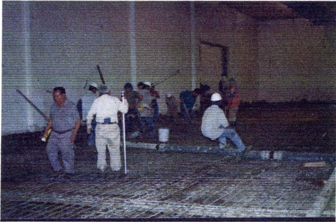
Fig. 33 Colado del concreto de la losa de rodamiento
