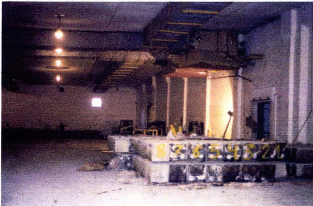
Fig. 24, Almacenaje de pilotes precolados
