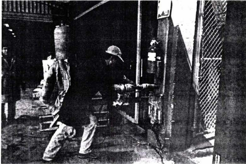
Fig. No. 5. Extracción de un corazón en una columna de andén
