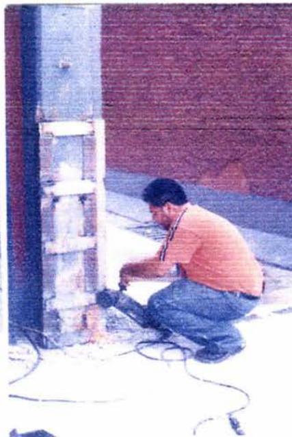
Fig. 34 Reforzamiento de las columnas de concreto dañadas
