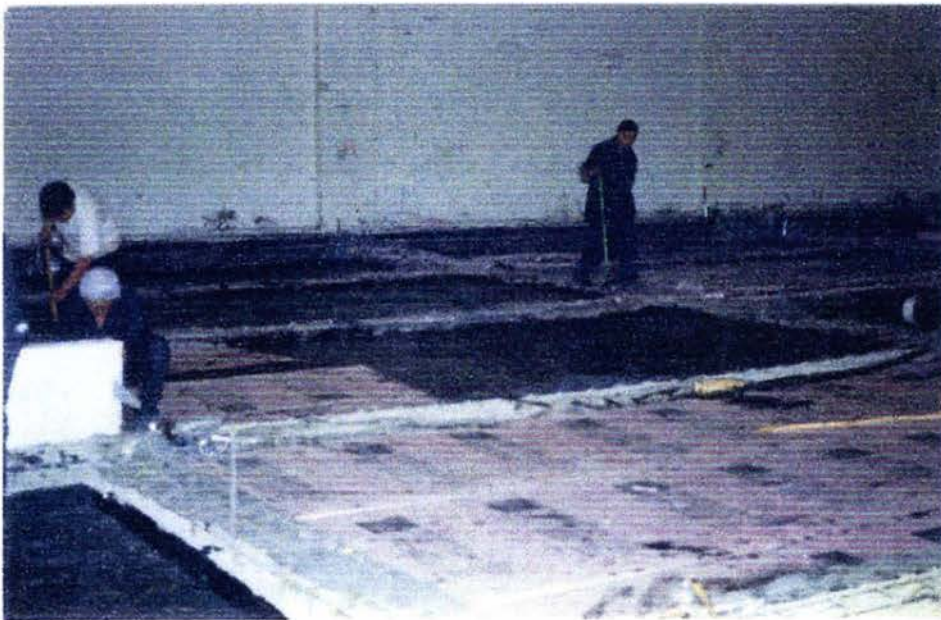
Fig 31. Colocación de material Térmico Aislante
