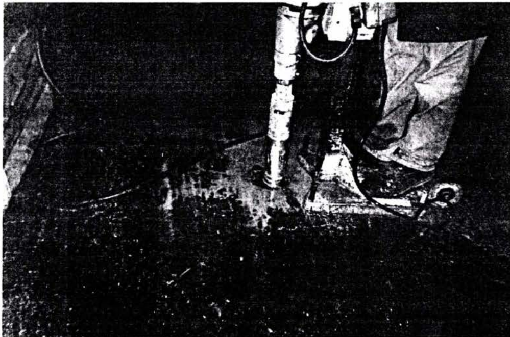
Fig. 4. Detalle de la extracción de un corazón de concreto en la losa de rodamiento
