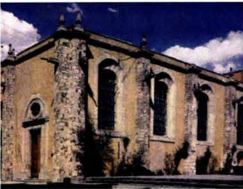
Fig. 1.15b Exterior de la Capilla de la Emperatriz, Sala de Fundición de la Antigua Casa de Moneda antes de la restauración
