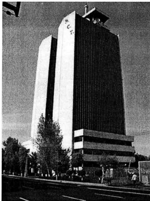
Figura 1.2 Vista noroeste del edificio
