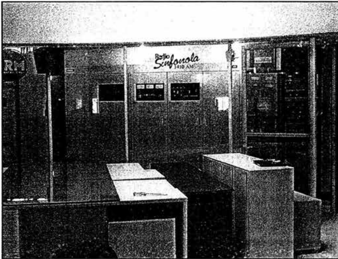
Fig. 1-5. Vista de la Sala de Transmisores
