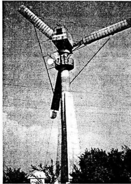
Figura 2.11. – Aerogenerador Gedser de 200 kW.
