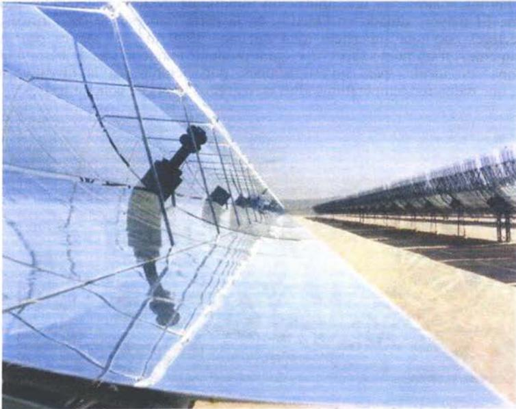
Los sistemas tipo canal parabólica usan reflectores parabólicos en una configuración de canal para enfocar la radiación solar directa sobre un tubo largo que corre a lo largo de su foco y que conduce al fluido de trabajo, el cual puede alcanzar temperaturas hasta de 500° C.
