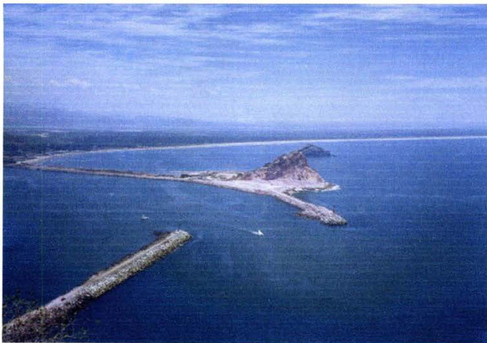
Fig. 8 Vista panorámica del rompeolas de Mazatlán
