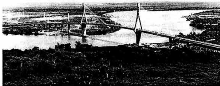
Fig 2.1 Vista del puente Coatzacoalcos II
