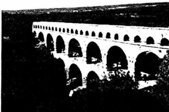
Figura 1.20 Acueducto romano de la ciudad de Nîmes (Francia), diseñado con arquitectura de triple arcada.
