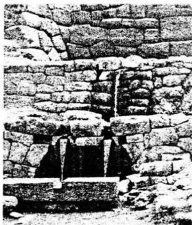
Figura 1.40 Fuente de Tampumachay cerca de Cuzco.
