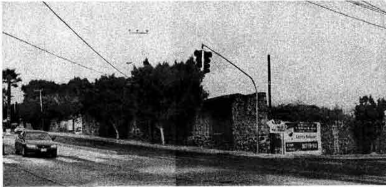
Fig.1: Vista del terreno desde la avenida Vicente Guerrero
