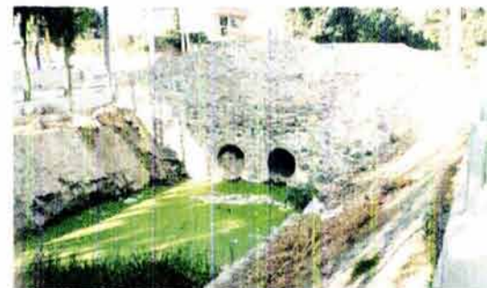
Fig. 4. Canal de aguas pluviales : riachuelo serpiente.
