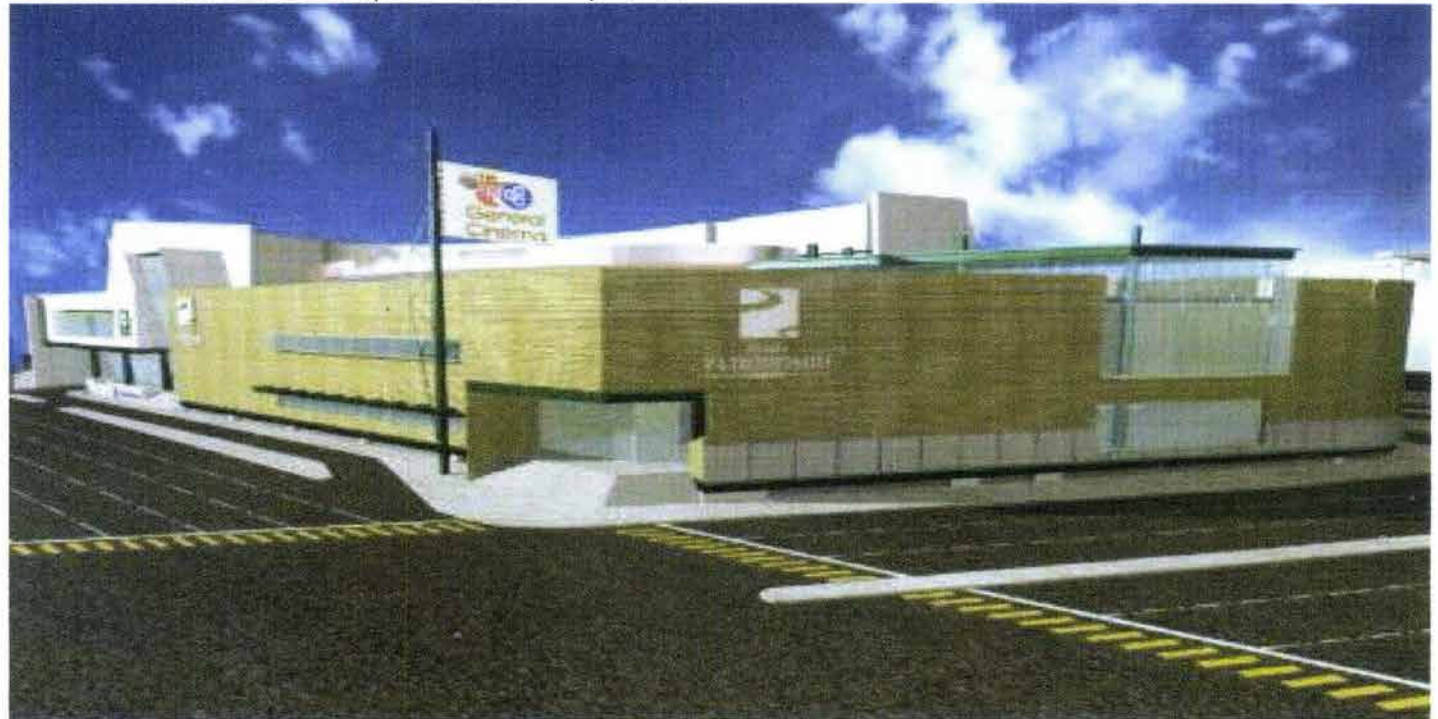
Fachada del Centro Comercial en calle Ciruelos esq. Duraznos col. Bosques de las Lomas
