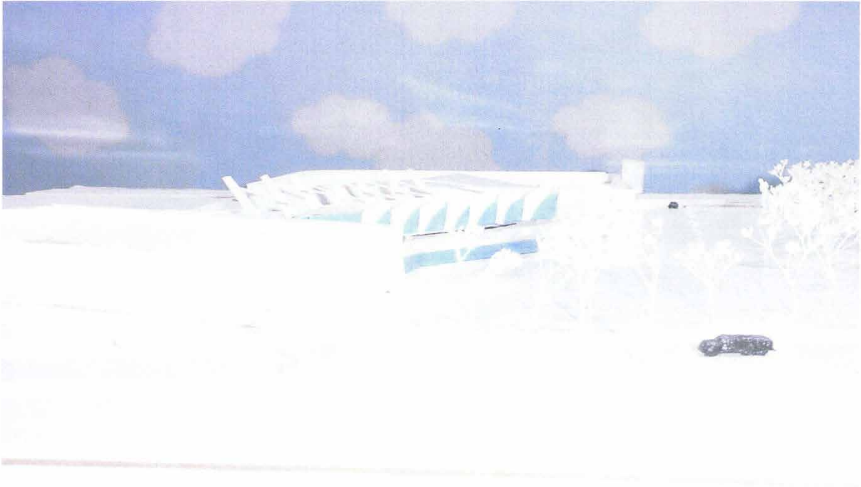
VISTA PONIENTE DEL CONJUNTO
