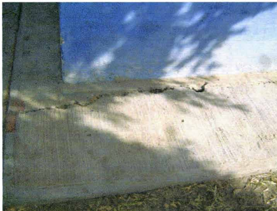
Foto 6.5 Levantamiento de banquetas
