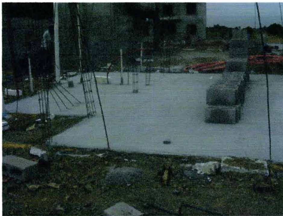
Foto 4.11 Losa terminada
