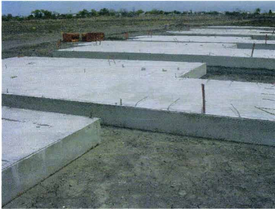
Foto 3.5 Tendido de la losas en el sitio
