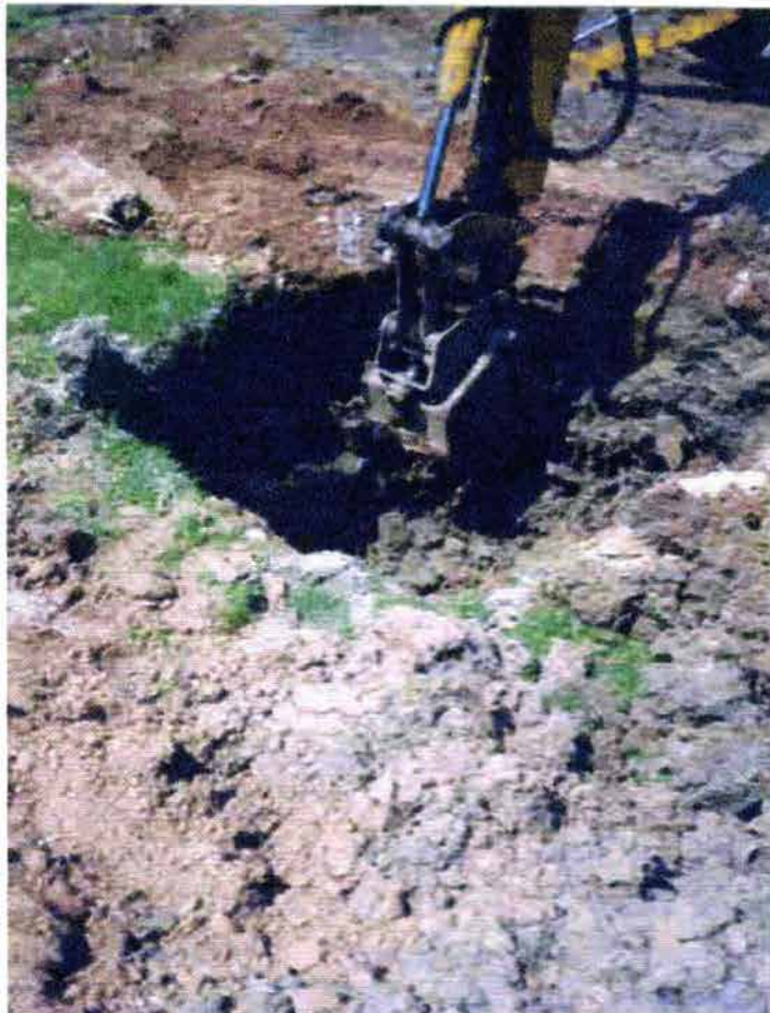
Foto 4.2 Excavación con equipo mecánico
