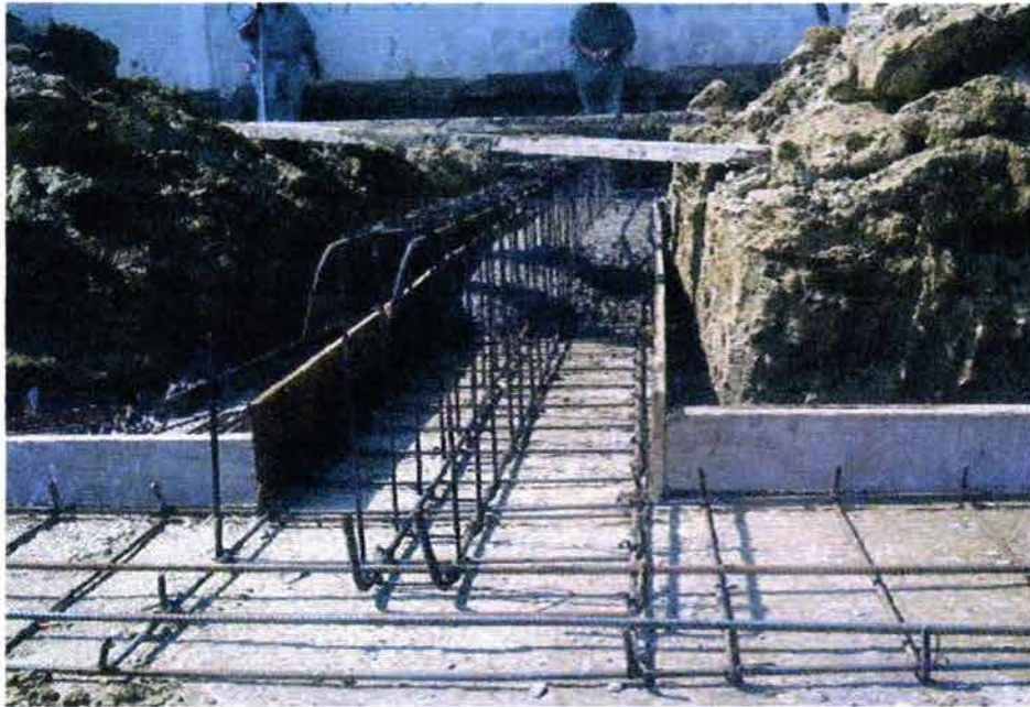
Foto 4.9 Colado de la zapata
