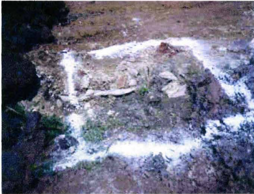
Foto 4.1 Trazo de una zapata aislada
