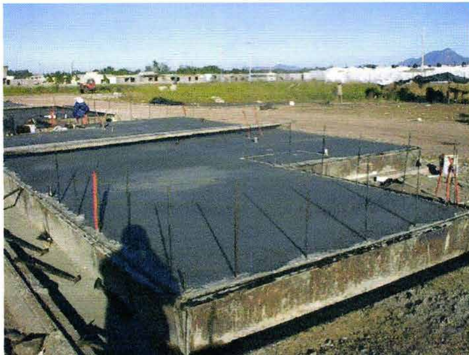
Foto 3.2 Colado y acabado superficial de la losa
