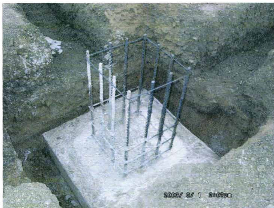
Foto 4.6 Descimbrado de la zapata
