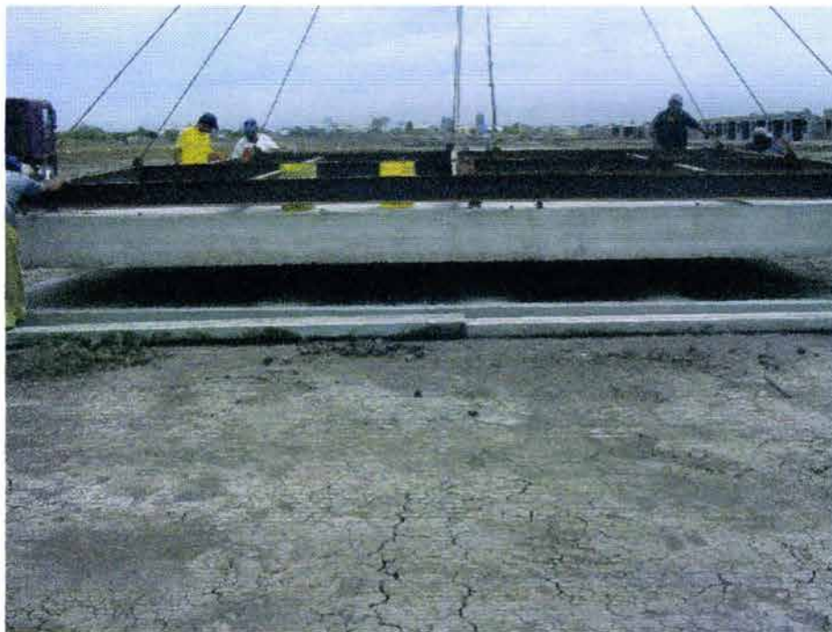
Foto 3.4 Colocación de la losa en el suelo
