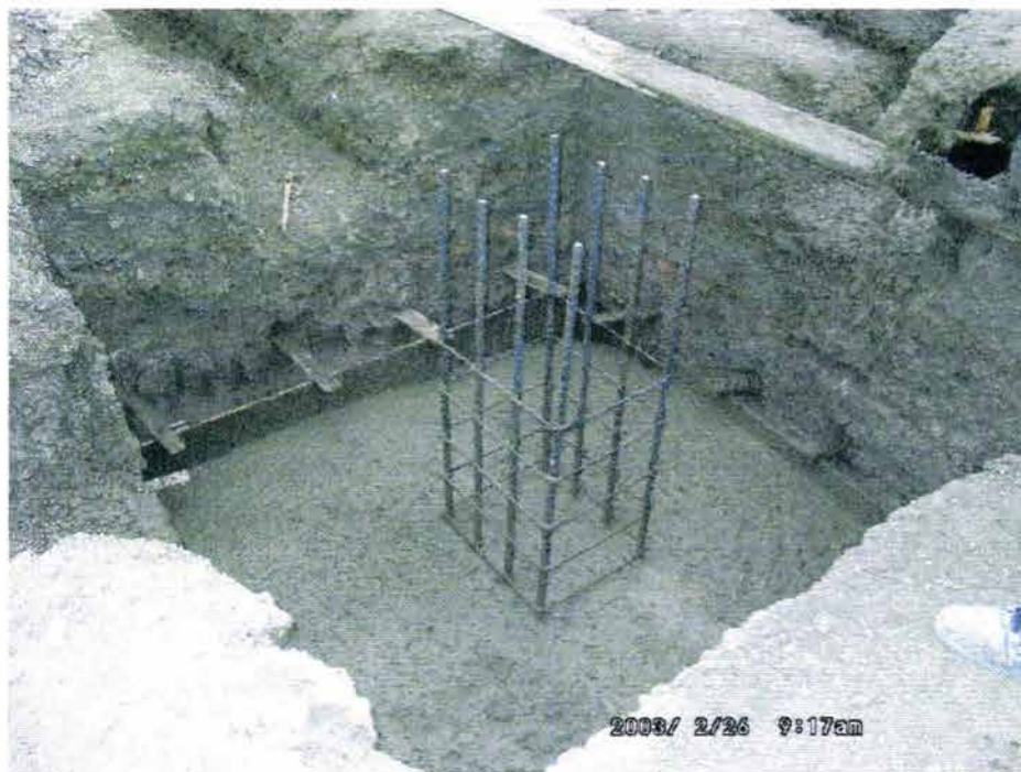
Foto 4.5 Colado de la zapata
