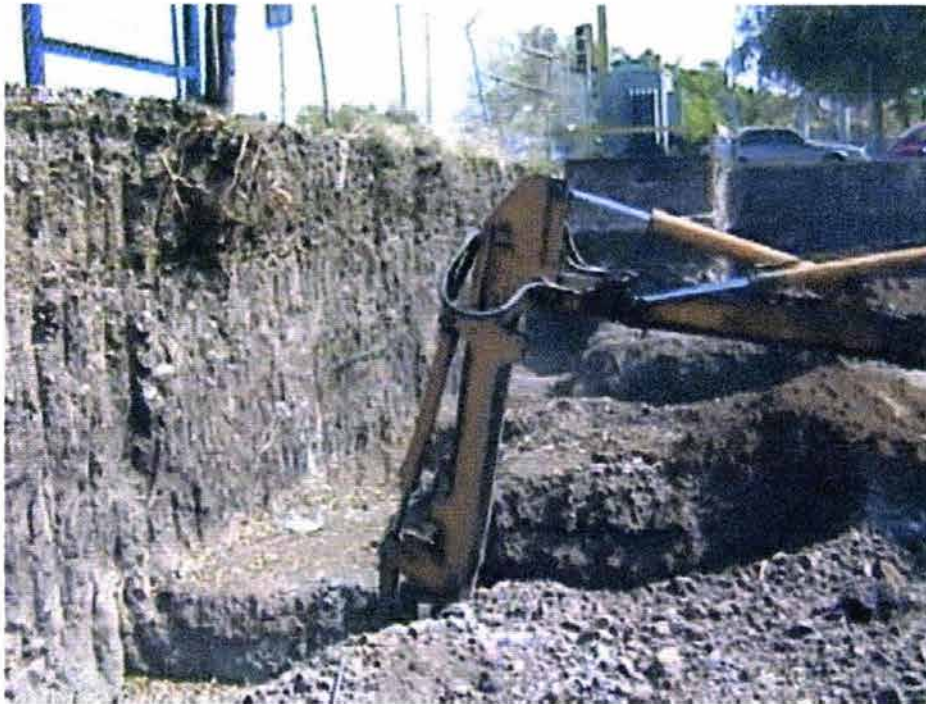
Foto 4.7 Excavación con equipo mecánico para zapatas corridas
