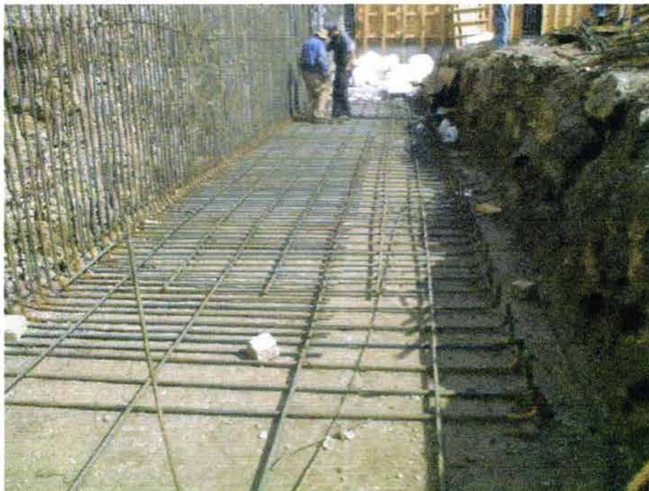
Foto 4.8 Plantilla y armado de la zapata de colindancia
