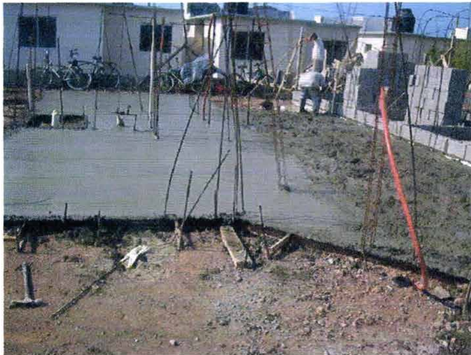
Foto 4.10 Colado de la losa de cimentación
