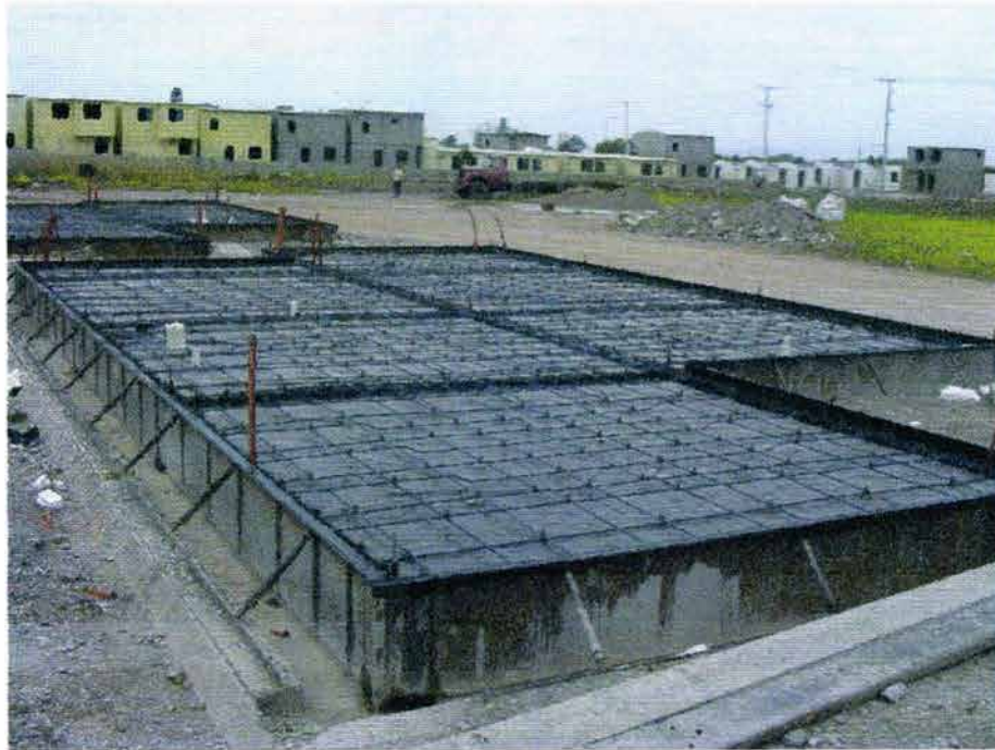
Foto 3.1 Armado, cimbrado y colocación de instalaciones de una losa de concreto prefabricada
