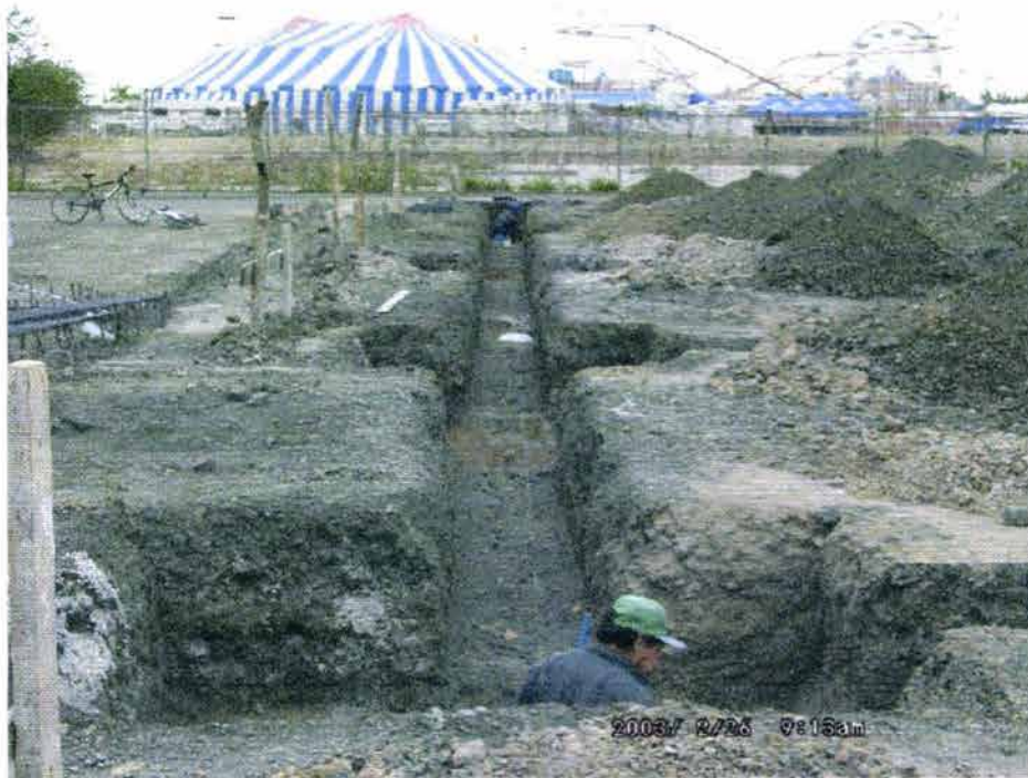
Foto 4.3 Nivelación de la base
