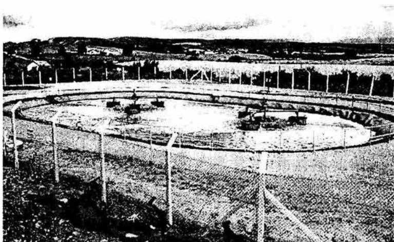
**Fig. II.3** Planta de tratamiento de lixiviados mediante lodos activados, Summerston, Escocia (Fuente: Robinson, H. and Baschurch, W., 1999).
