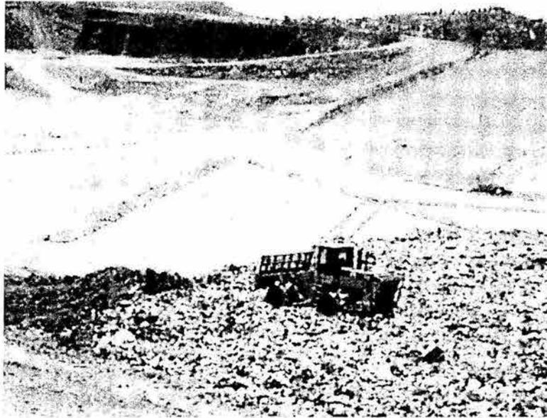
Fig. IV.2 Ejemplo de un arreglo de canales para drenaje de lixiviados (R. S. Tlalnepantla).
