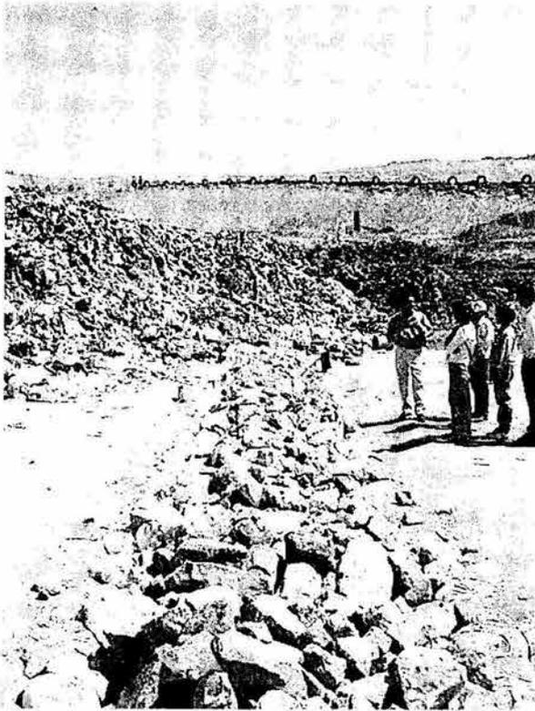
Fig. IV.4 Vista final de un canal colector de lixiviados relleno de material pétreo. Bajo la capa superficial de piedra angulosa se encuentra un filtro geotextil y más abajo una capa de boleos o cantos rodados colocados a mano sobre la geomembrana impermeable (R. S. Tlalnepantla).
