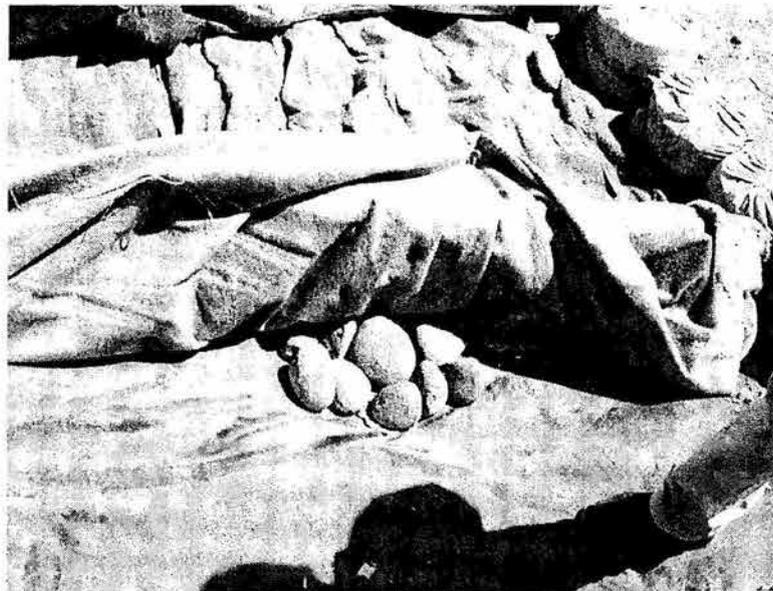
Fig. IV.3 Detalle del relleno de material pétreo en un canal colector de lixiviados (R. S. Tlalnepantla).
