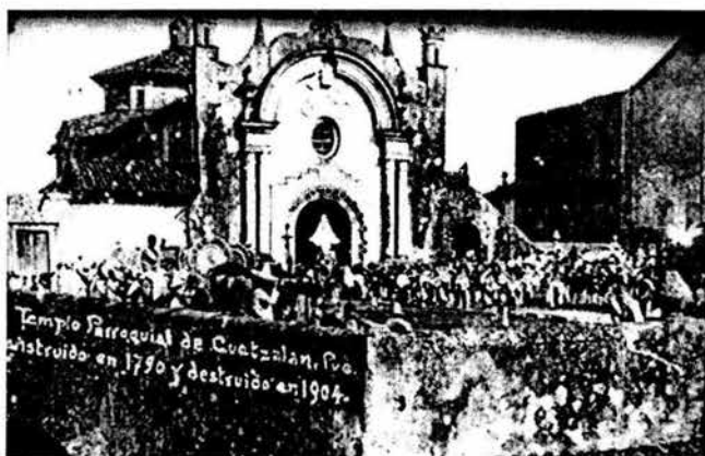
Templo parroquial de Cuetzalan, construido en 1790 y destruido en 1904. Foto de la peluquería de Don Aquino, Cuetzalan.
