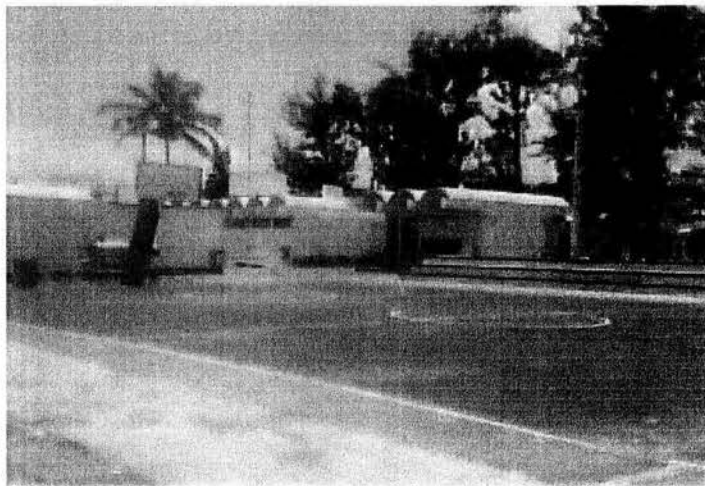
Figura No. 15 Vista desde el interior de la Unidad Deportiva, donde se puede apreciar los baños vestidores, oficinas administrativas y la cancha de básquetbol..
