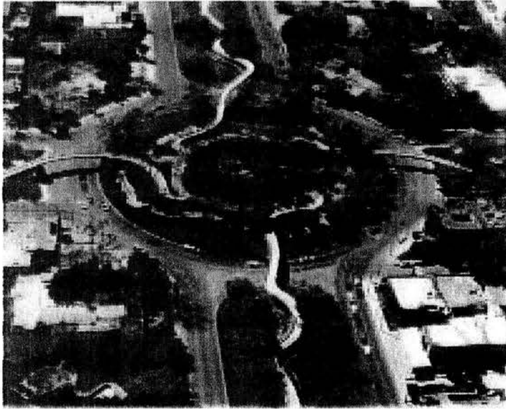
Figura No. 1 Vista panorámica del Paseo de los Duendes en San Pedro Garza García en Nuevo León.
