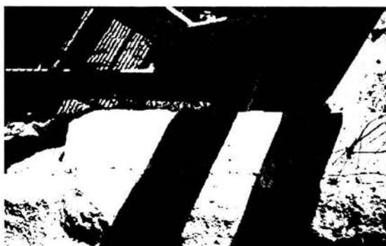
**Fig. 2.- Vista del soporte de concreto y la estructura del puente, en la cual se pueden apreciar los puntos de corrosión.**
