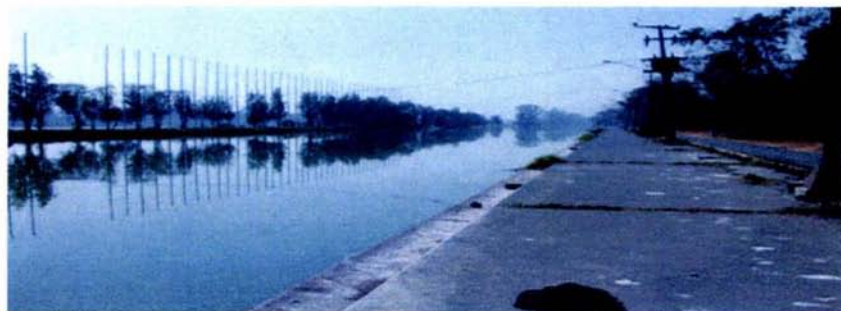
Figura 5. Panorámica de la pista de remo y canotaje.
