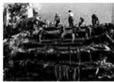
Rescate de víctimas y remoción de escombros, Ciudad de México, 1985.
