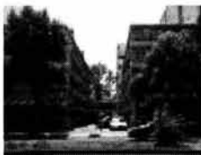
Edificio en Insurgentes , Ciudad de México, 2004.
