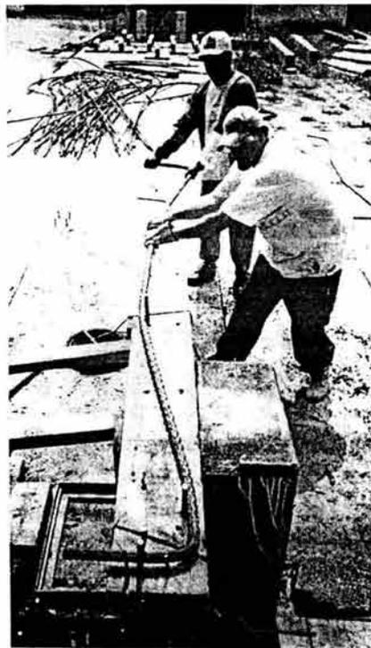
Figura 4.2 Doblado del acero longitudinal para obtener el ángulo de acartelamiento.
