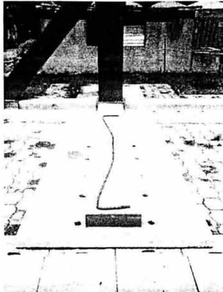
Figura 4.3 Acero longitudinal continuo y doblado.
