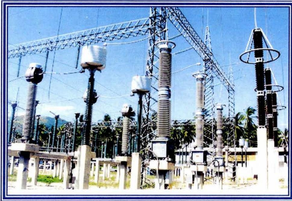
**Ilustración 7 Transformador de Corriente.**
