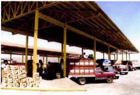
CENTRO DE ACOPIO DE NOPAL EN MILPA ALTA A PARTIR DE 1999
