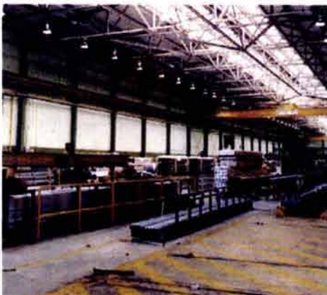
Iluminación en áreas de procesamiento
