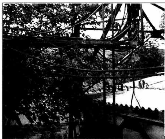
Recorrido de la escalerilla del Pie de Torre a pasamuros externo
