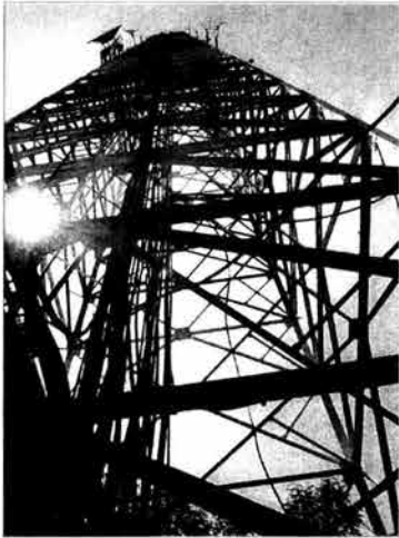
Recorrido de las líneas de transmisión en la Torre
