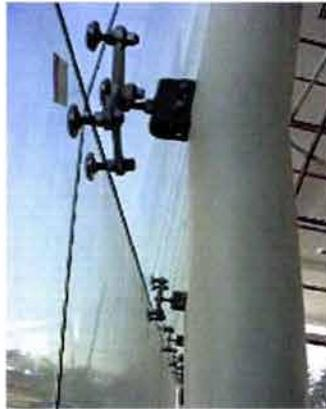
Fig. 56.- Ejemplo de cómo funciona el sistema de araña.
