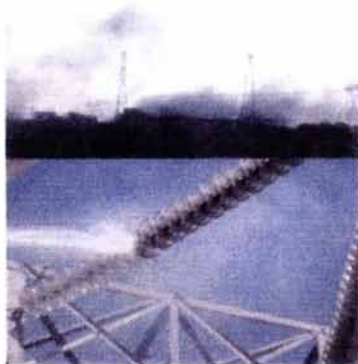
Figura 5.8 Lavado de aislamiento en líneas de transmisión expuestas a alta contaminación industrial y salina.
