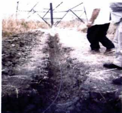
Figura 7.7 Mejoramiento de sistema de tierras en la línea de transmisión de 230 kV Escarcega-93010-Ticul [4].
