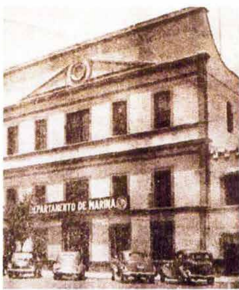
Antiguo edificio del Departamento de Marina.
