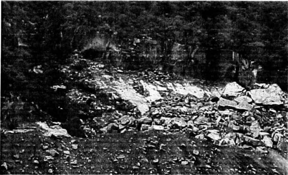
Fig. 1.5 Falla Plana en un talud.
