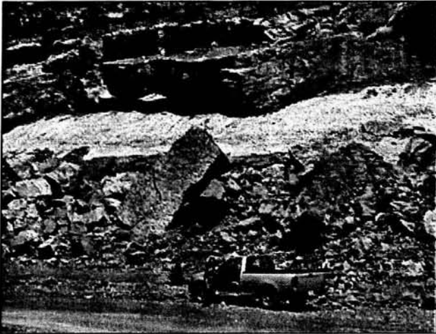
25.- FALLA MASIVA EN DOS PLANOS, OBSÉRVESE LA MAGNITUD DE LOS BLOQUES
