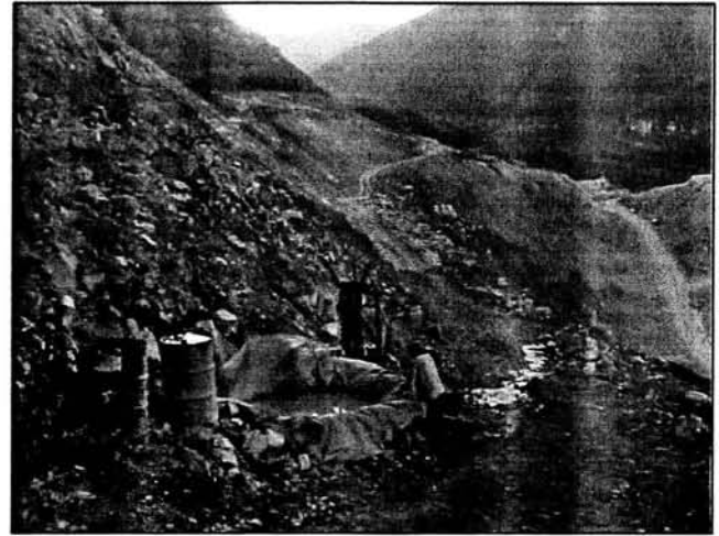
50.- ALMACENAMIENTO DE AGUA PARA LAS EXPLORACIONES DIRECTAS CON MÁQUINA ROTATORIA
