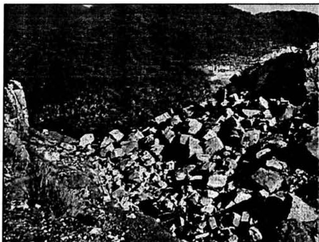
3.- VOLTEO DE BLOQUES HACIA EL EJE DE LA CARRETERA.
