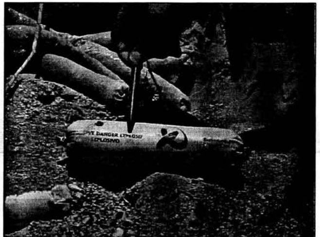
48.- EXPLOSIVOS UTILIZADOS EN LAS VOLADURAS
