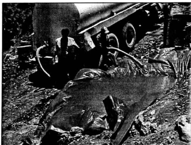
53.- ALMACENAMIENTO DE AGUA PARA LA UTILIZACIÓN EN LA EXTRACCIÓN DE NÚCLEOS.
