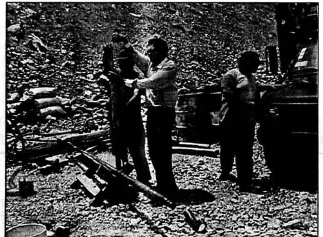
24.- EXTRACCIÓN DE NÚCLEOS DE ROCA
