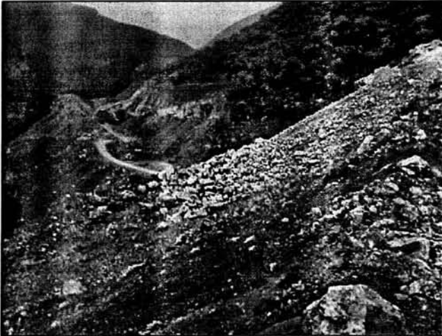
13.- LÍNEA DE CEROS DE INICIO PARA EL CORTE DE LOS TALUDES
