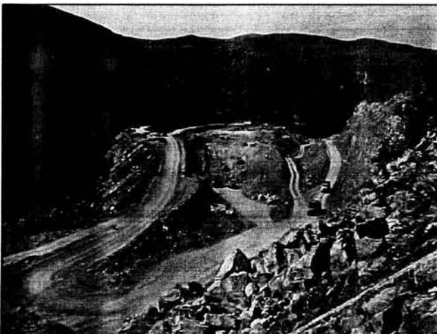
31.- CAMINOS DE ACCESO, REALIZADOS PARA LLEGAR A LA LÍNEA DE CEROS DE LOS TALUDES
