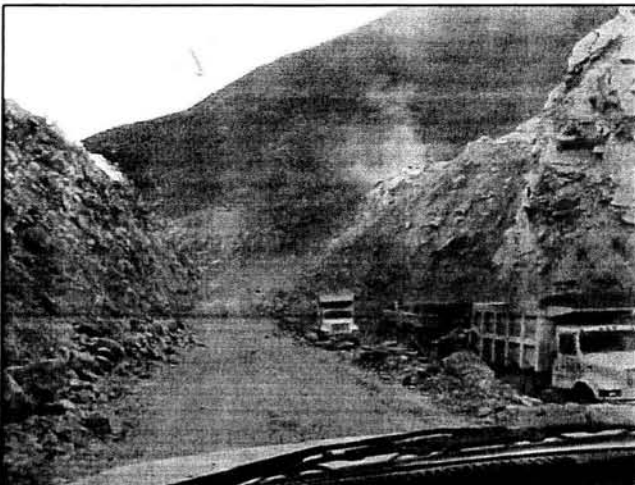
43.- AVANCES EN LOS CORTES EN LOS TALUDES.
