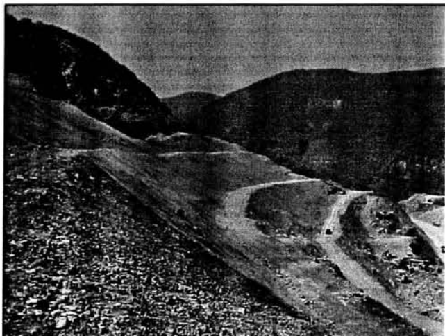
65.- ESTABILIZACIÓN DE CORTES EMPLEANDO BERMAS
