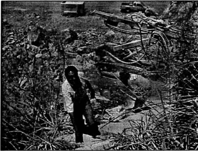
49.- SUPERVISIÓN DE LA PLANTILLA DE DINAMITACIÓN PARA LAS VOLADURAS.
