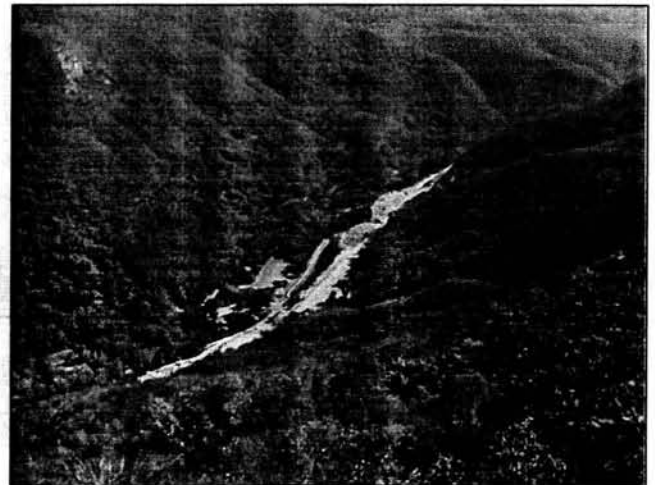
12.- AVANCES DEL TRAZO DE LA CARRETERA
