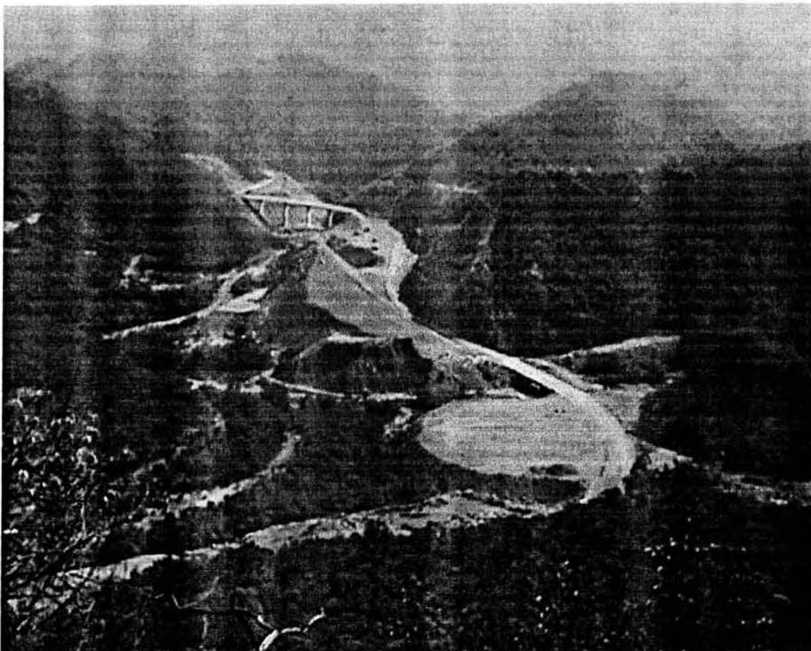
Fig. 5.1.1 Tramo carretero del 10+660 al 11+400.
