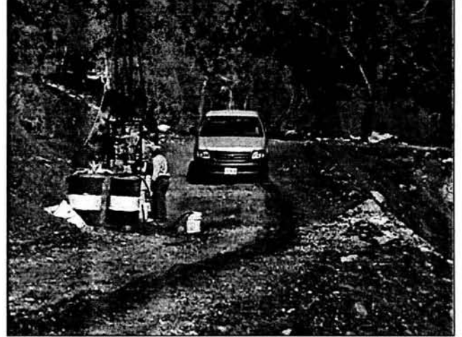
6.- EXPLORACIÓN DIRECTA, EMPLEANDO MÁQUINA ROTATORIA TIPO LONG YEAR.
