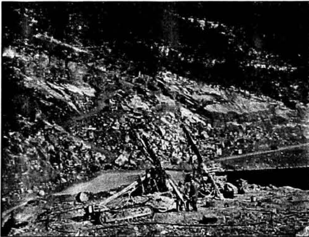
29.- "TRACK DRILL" TRABAJANDO EN LA PLANTILLA PARA LA DINAMITACIÓN
