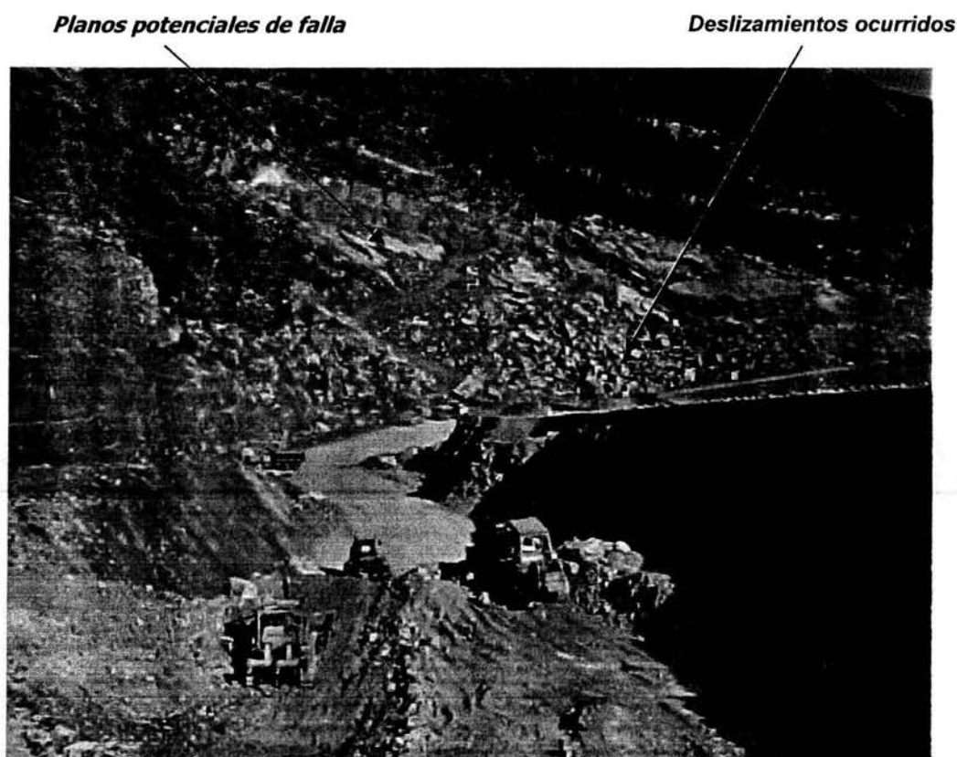
Figura 5.3.2. Panorámica de las estructuras geológicas en estudio.
