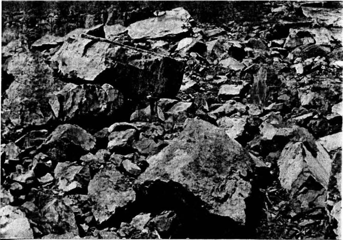
Figura 5.1.2. Zona de los “grandes derrumbes”
