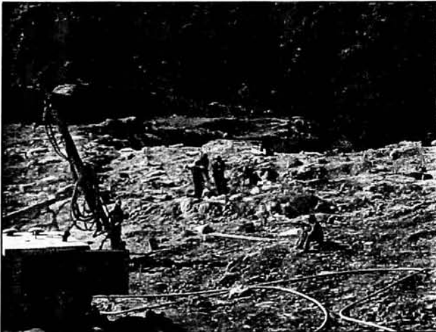
33.- SUPERVISIÓN DE LAS PLANTILLAS DE BARRENACIÓN PARA LAS VOLADURAS.
