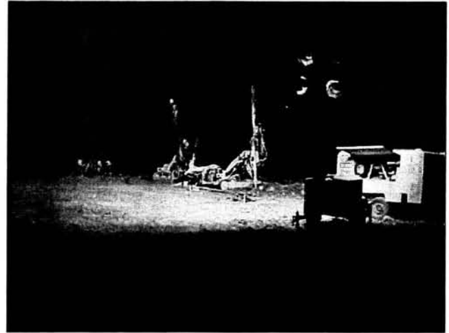
42.- "TRACK DRILL" PERFORANDO LA PLANTILLA PARA LAS VOLADURAS.
