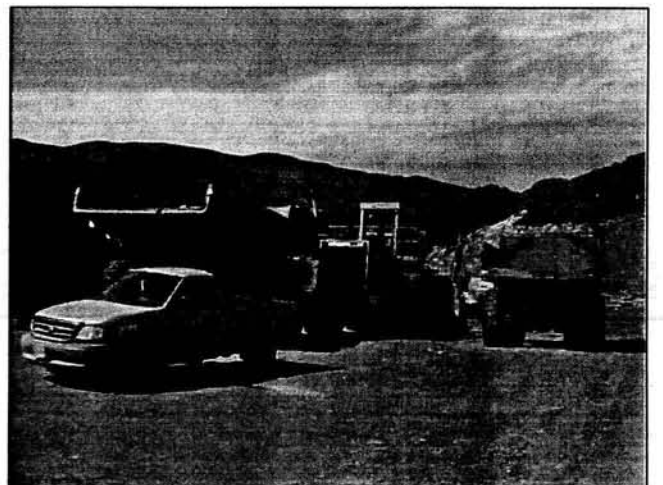
32.- MAQUINARIA EMPLEADA EN LA REALIZACIÓN DE LOS CORTES DE LOS TALUDES DE ROCA.
