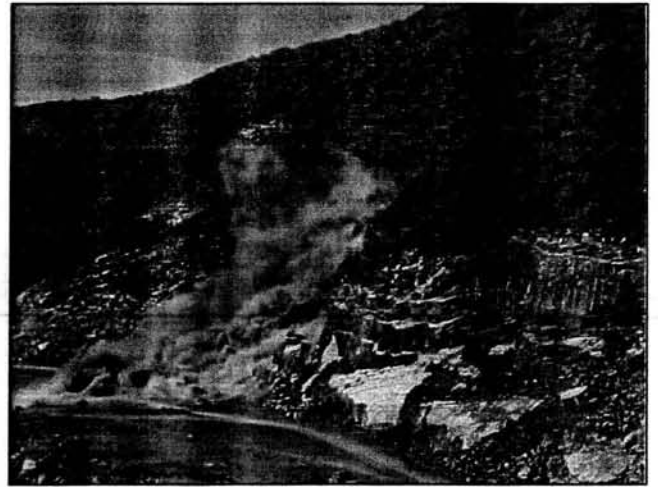
60.- RETARDO DE ENCENDIDO DE LA VOLADURA
