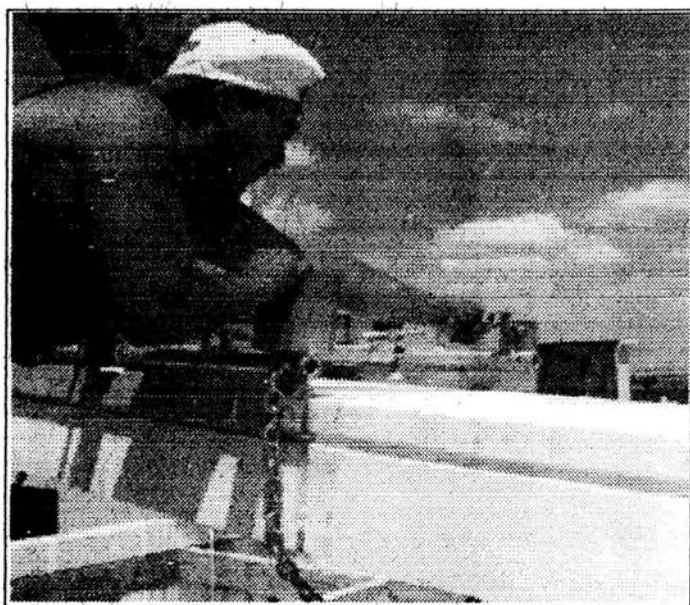
Figura 4.16 En la fotografía se muestra la descarga del panel en su sitio final, los elementos durante el transporte en la grúa deben asegurarse en forma adecuada para evitar posibles accidentes.
