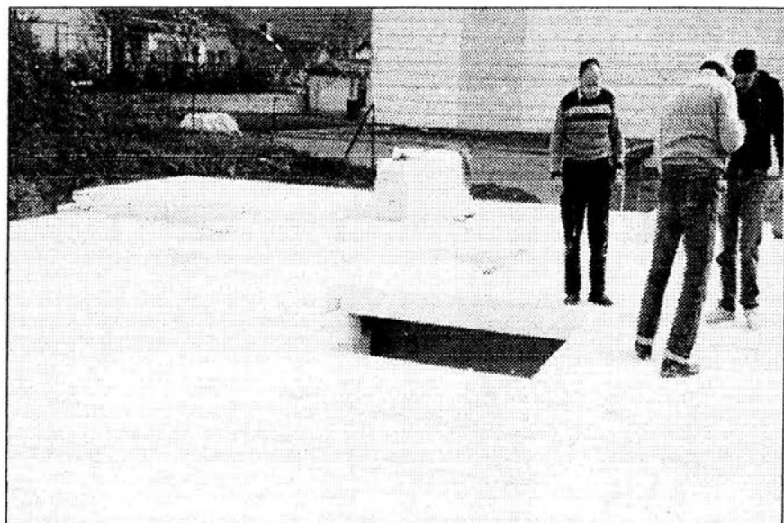
Figura 4.18 En la fotografía se muestra el aspecto de una losa formada por paneles de concreto celular con acero de refuerzo.
