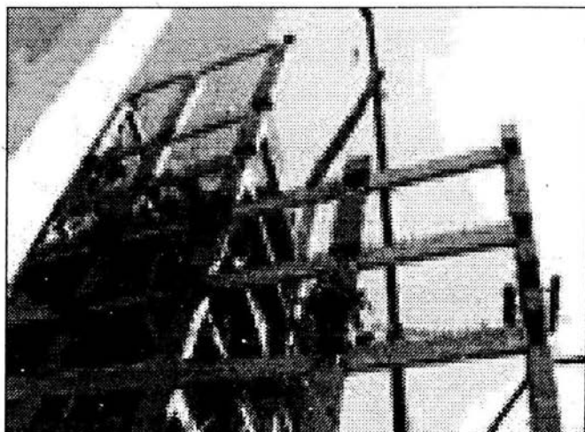
Figura 2.7 En la fotografía se muestra la estructura de acero de un edificio en el cual se colocan anclajes para el posterior montaje de elementos prefabricados de concreto, con la finalidad de formar la fachada del edificio.
