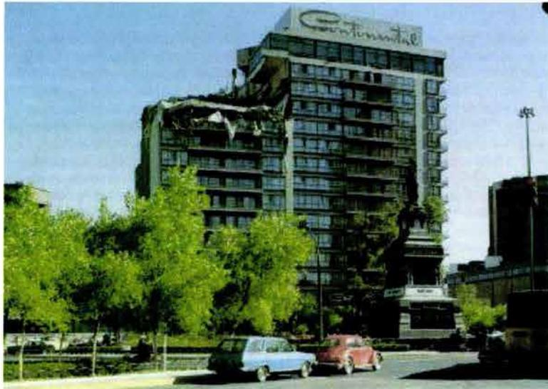
Fig. 32.- Falla por concentración de masa en el techo del edificio, en el sismo de septiembre de 1985.
