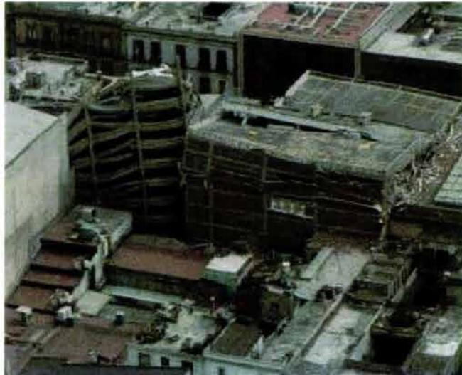
Fig. 35.- Falla por flexibilidad estructural en edificio, sismo de septiembre de 1985.
