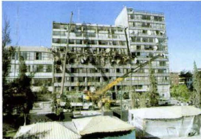
*Fig. 33.- Falla por columna corta y golpeteo con el edificio de la izquierda, en el sismo de septiembre de 1985.*
