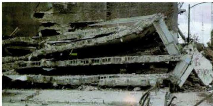
Fig. 37.- Falla por diferencias de rigidez en elementos estructurales verticales.
