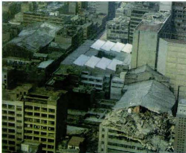
Fig. 28.- Falla en el edificio por longitud excesiva en planta, sismo de septiembre de 1985.
