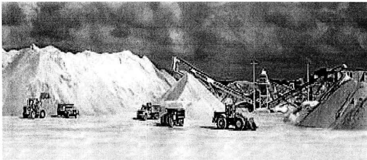
Fotografía IV.1.- Banco de agregados.
