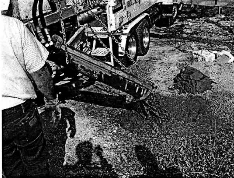
Fotografía III.10.- Tiro de mezcla para purgar el sistema y verificar la mezcla.
