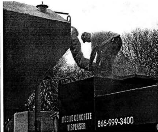
Fotografía IV.4 (Izquierda).- Se muestra un silo con forma de un prisma triangular, el cual es el que se encarga de abastecer de cemento. Fotografía IV.5 (Derecha).-Nótese como el cemento es descargado por la parte superior del mezclador en la cual se encuentra la abertura con su tapa.
