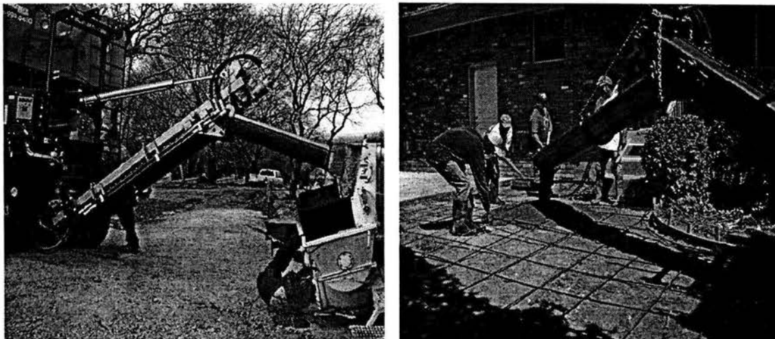
Fotografías III.11 y III.12.- En las fotografías se muestra la forma de entregar el concreto a pie de obra, notando que el sistema del tornillo es ajustable a cierto nivel. En el lado izquierdo obsérvese cómo el tornillo descarga el concreto por una canaleta a la tolva de la bomba. Del lado derecho nótese que también se entrega el concreto a nivel del suelo si se requiere.
