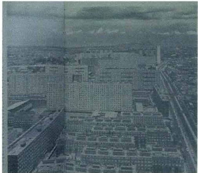
Conjunto habitacional Nonoalco-Tlatelolco. Se aprecia dos desarrollos que no corren paralelos, uno la ciudad existente y otro el conjunto proyectado en base a ideales modernos.
