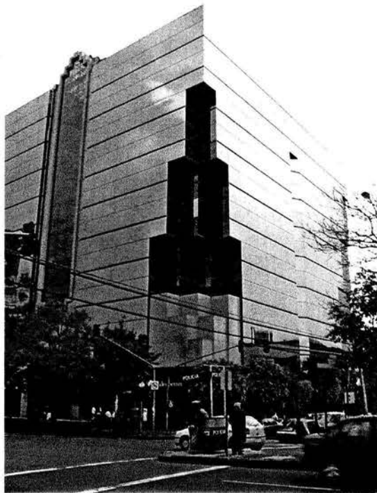
Edificio de oficinas colindante ( fachadas en vidrio espejo azul )
