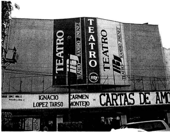
Vista de la fachada sobre Av. División del Norte
