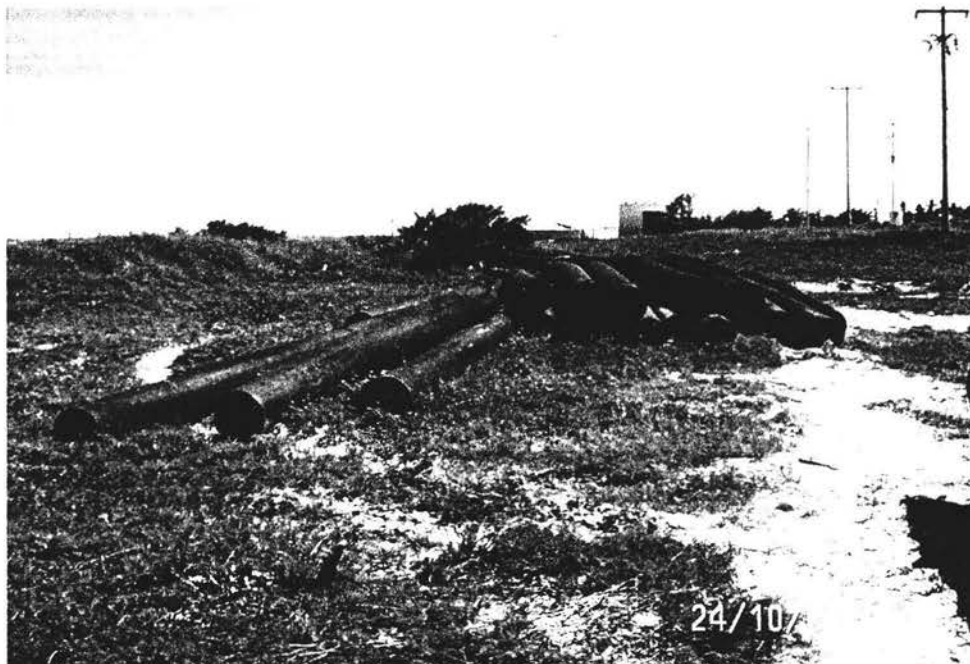
Foto.5.18 Tubería rígida Extrupack 16" en el patio de maniobras El Cuyo, Yucatán 24 de octubre 2002
