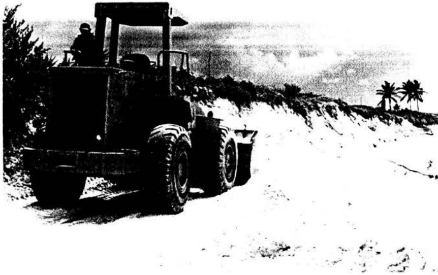
Foto 5.8 Empuje del material de depósito playa Oeste. El Cuyo, Yucatán 8 de Agosto 2002
