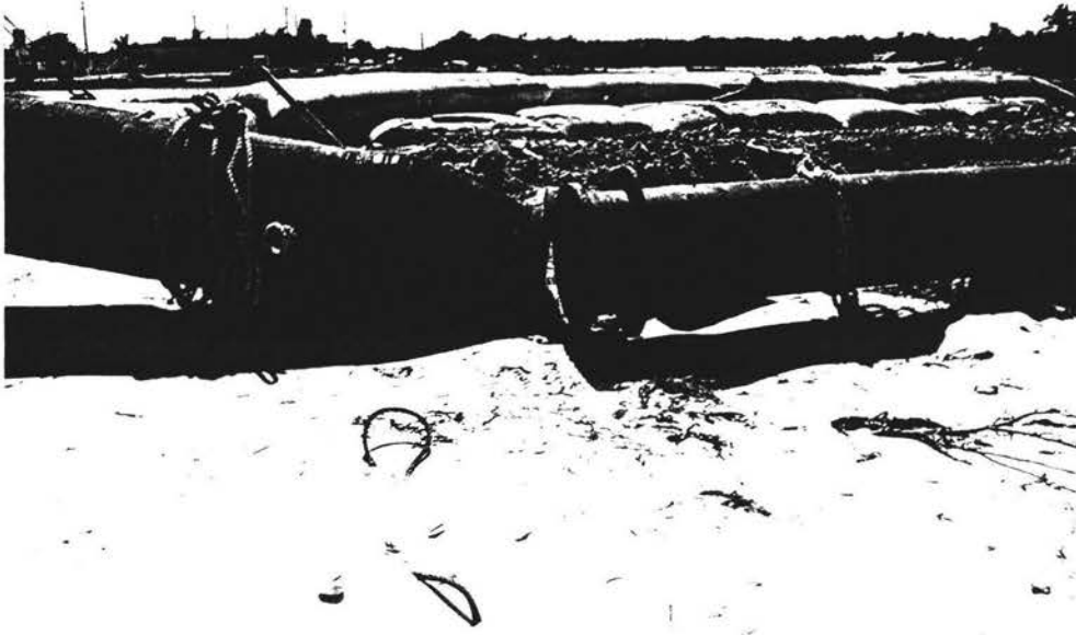
Foto 5.21 Conexión de tubería flexible de 18" a tubería rígida 16". El Cuyo, Yucatán 9 de Noviembre de 2002
