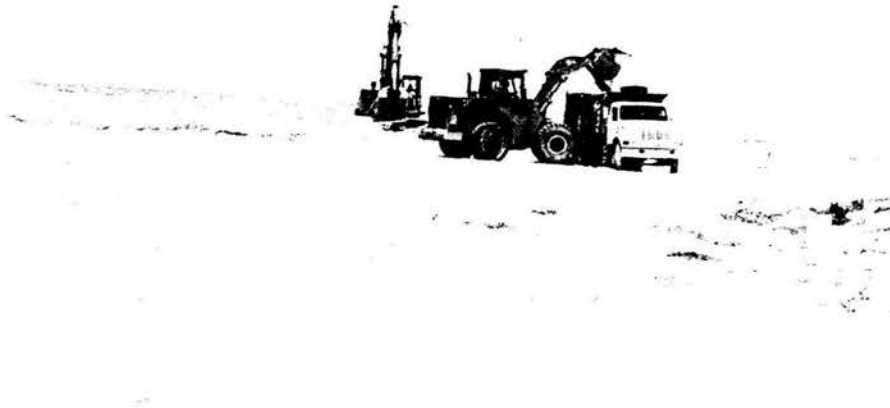
Foto 5.4 Excavación y carga, transporte de material. Playa Este. El Cuyo, Yucatán 13 de Agosto 2002
