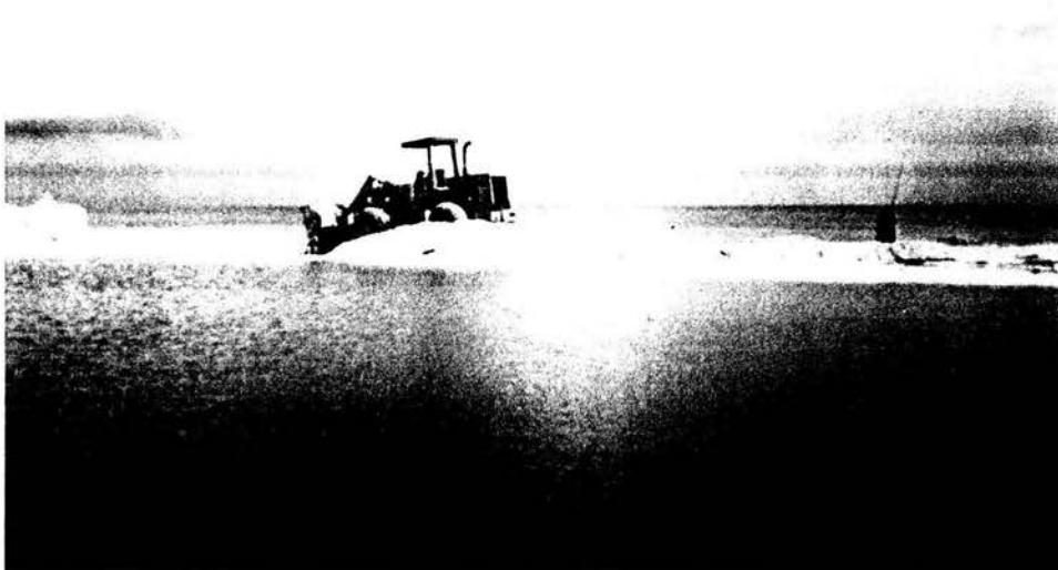
Foto 5.14 Reparación de rotura del borde de playa. El Cuyo, Yucatán 12 de Septiembre de 2002
