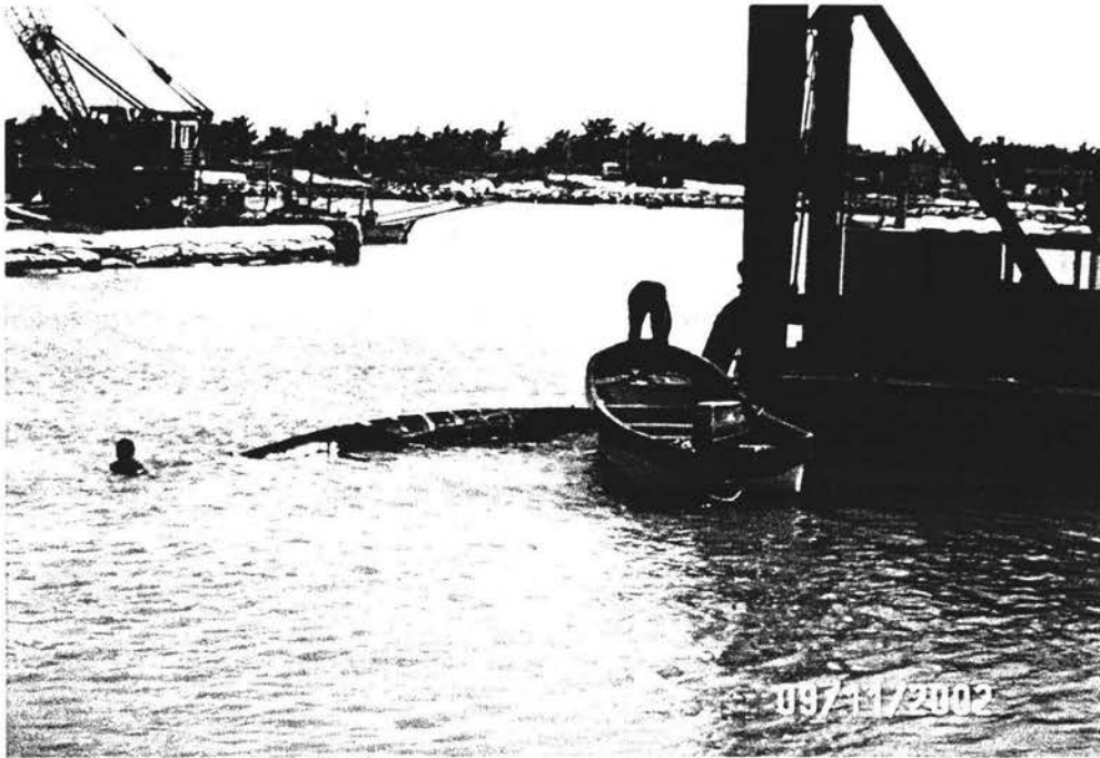
Foto.5.19 Conexión de la tubería flexible a la descarga de la draga estacionaria con cortador " Makax " El Cuyo, Yucatán 9 de noviembre del 2002
