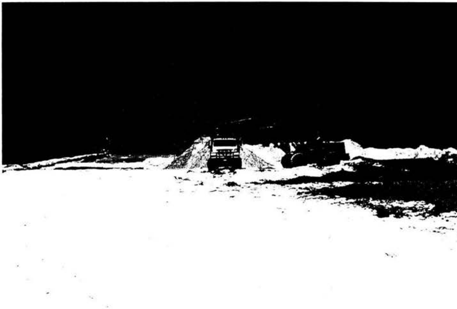
Foto 5.10 Carga material de excavación. El Cuyo, Yucatán 13 de Agosto 2002
