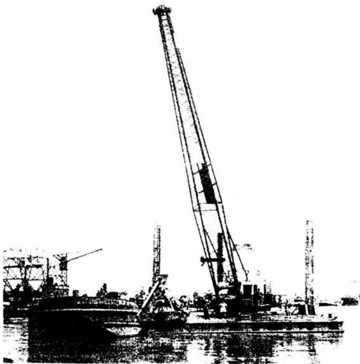
Foto 4.4 Draga estacionaria de grúa que va a descargar los productos dragados en el gánguil de la izquierda
