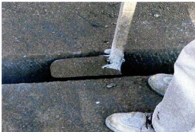
Foto 16 Limpieza del fondo de la zanja
