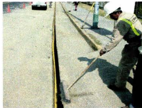
Foto 38 Tendido de tubería
