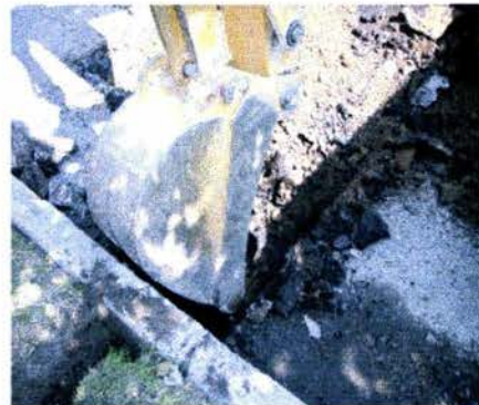
Foto 55 Excavación de caja de servicio con retroexcavadora
