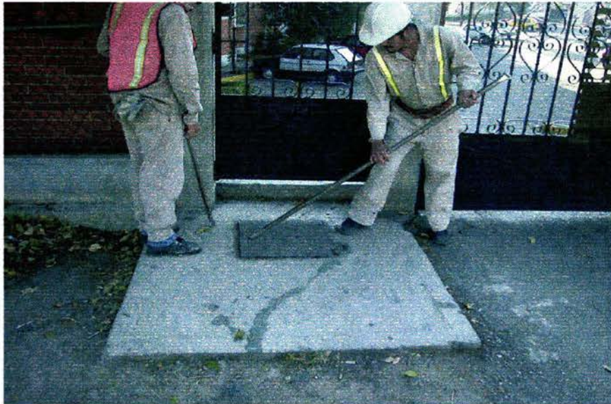
Sondeo de obras inducidas por métodos manuales Foto 1
