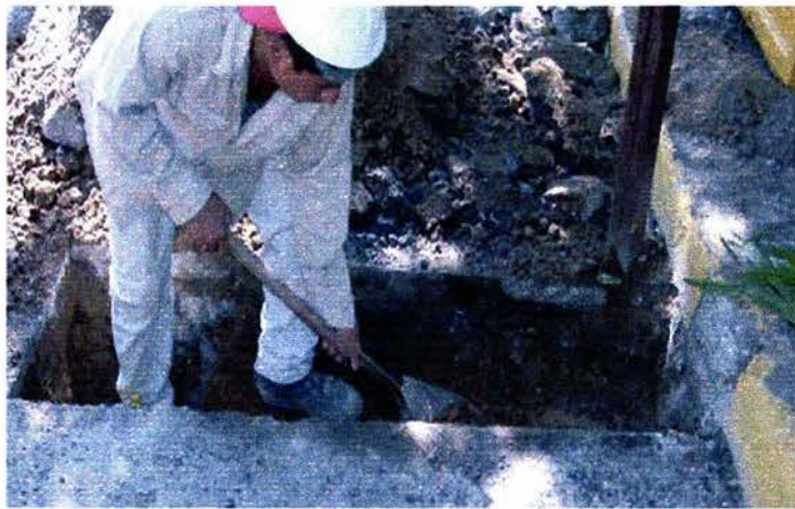
Sondeo de obras inducidas por métodos manuales Foto 2
