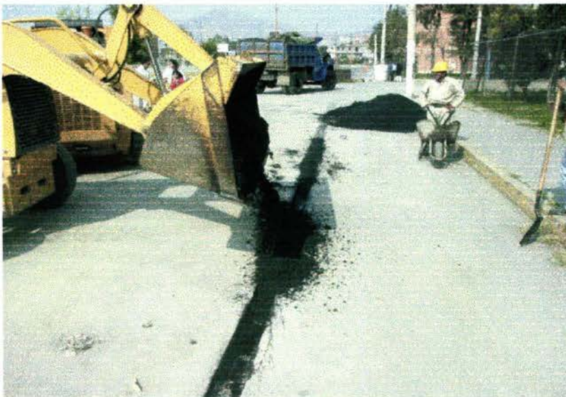
Foto 46 Colocación del asfalto en dos capas.
