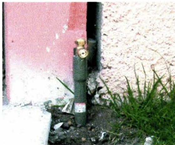
Foto 52 Colocación de una toma.
