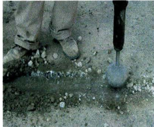
Foto 67 Compactación en zanja
