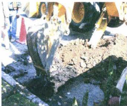
Foto 55 Excavación de caja de servicio con retroexcavadora
