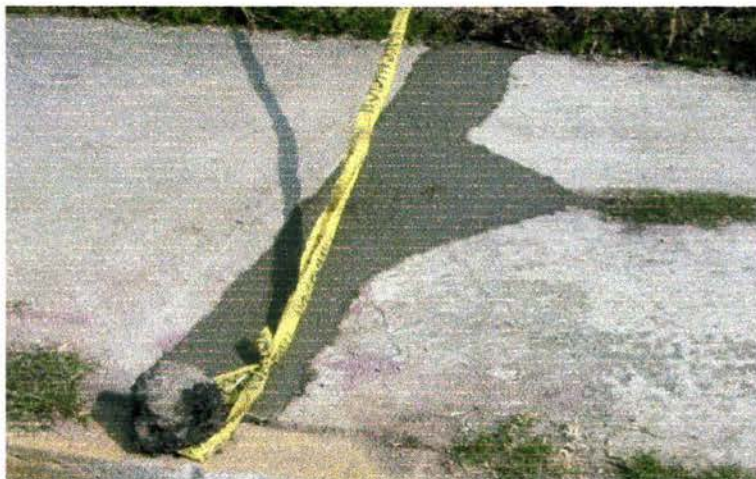
Foto 43 Reposición de banqueta de concreto.
