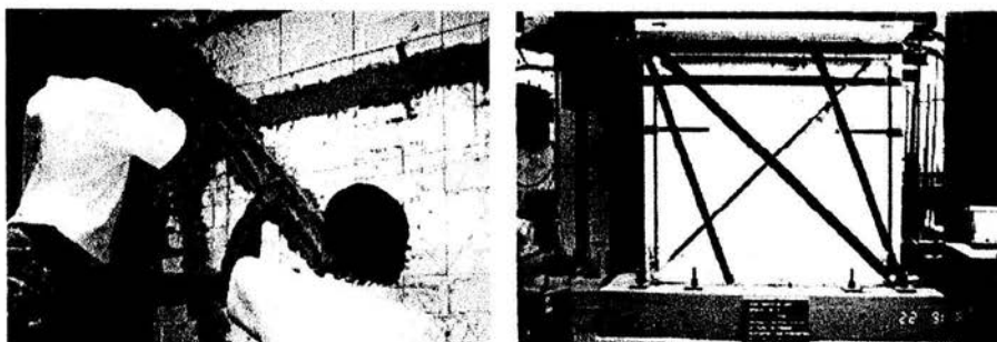
Figura 6.15 Rehabilitación de un muro de mampostería usando bandas de carbono.
