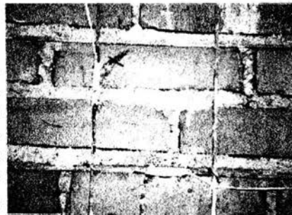
Figura 6.11 Anclaje de malla metálica a muro de mampostería con clavos.
