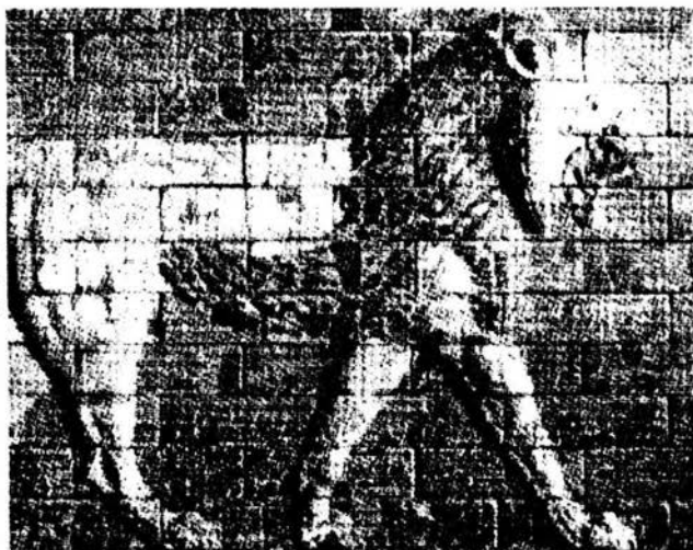
Figura 1.2 Muro de unidades de arcilla decorativas : esmaltadas y vitrificadas ( Babilonia, primer milenio antes de Cristo ).
