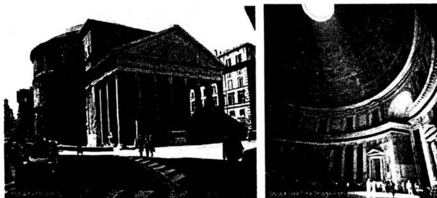
Figura 1.7 El panteón de Agripa en Roma construido entre 118 y 128 edificio de planta circular de mampostería y concreto con acabado de ladrillo en el exterior y mármol en el interior cubierto con una gran cúpula de concreto (ver ref. 22).
