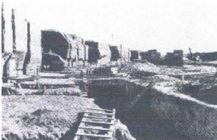
Estadio Olímpico Universitario en proceso de Construcción
