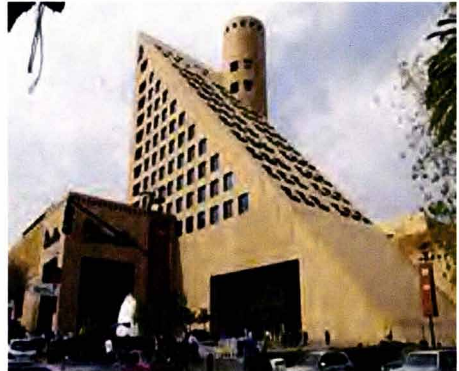
Fachada de la plaza Moliere vista desde Moliere esq. Homero
