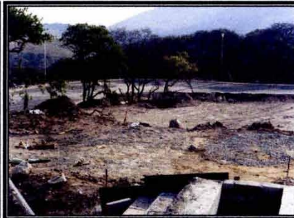
VISTA INTERIOR DEL PREDIO
