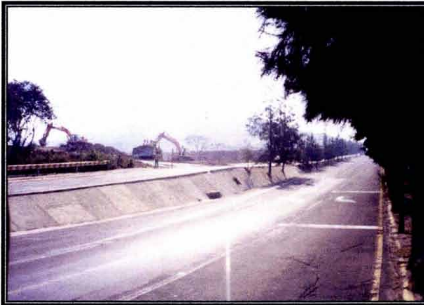
AV. DR. JIMÉNEZ CANTU SUR – NORTE CON ACCESO AL PREDIO
