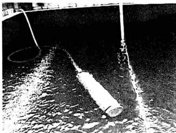
Fig. 22 Filtro con malla de 100 micras para bajar nivel
