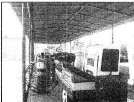
Figura 14. Equipo de bombeo contra incendios, operado con motor a combustión
